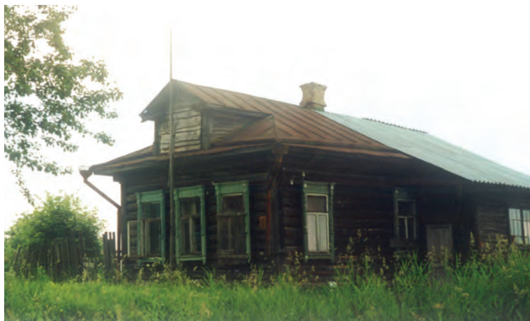
Рис. 16. Дом Спиридона (ремонт)
