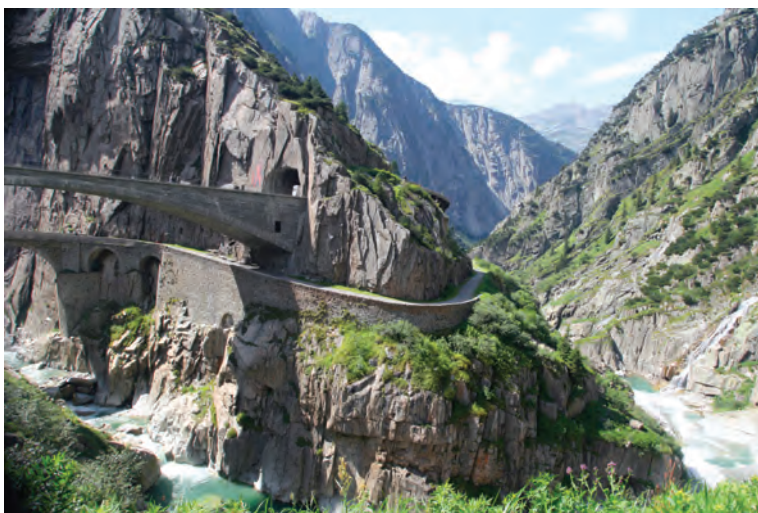
Рис. 5. Вид на «Чертов мост» через реку Рёйс (Швейцария). Фото В. Конева. 2009 г.
