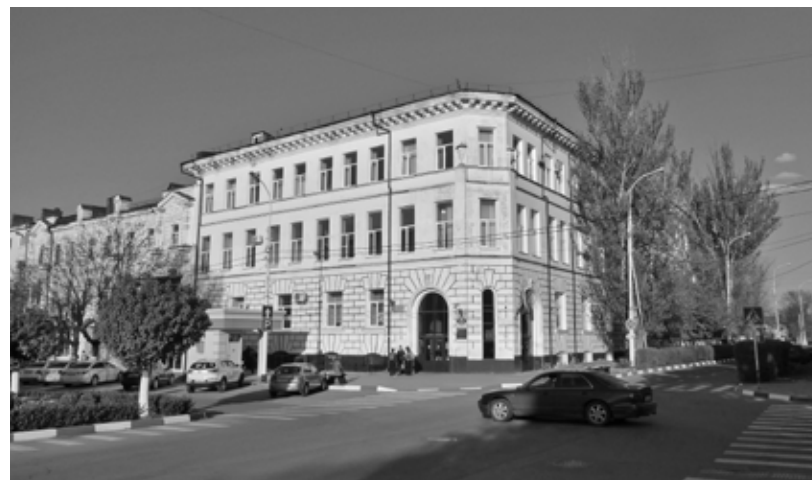
Рис. 8. Фрагмент застройки середины XX в.: угол ул. им. Кирова и ул. Комсомольской. Фото АЦ «Югреставрация», 2018
