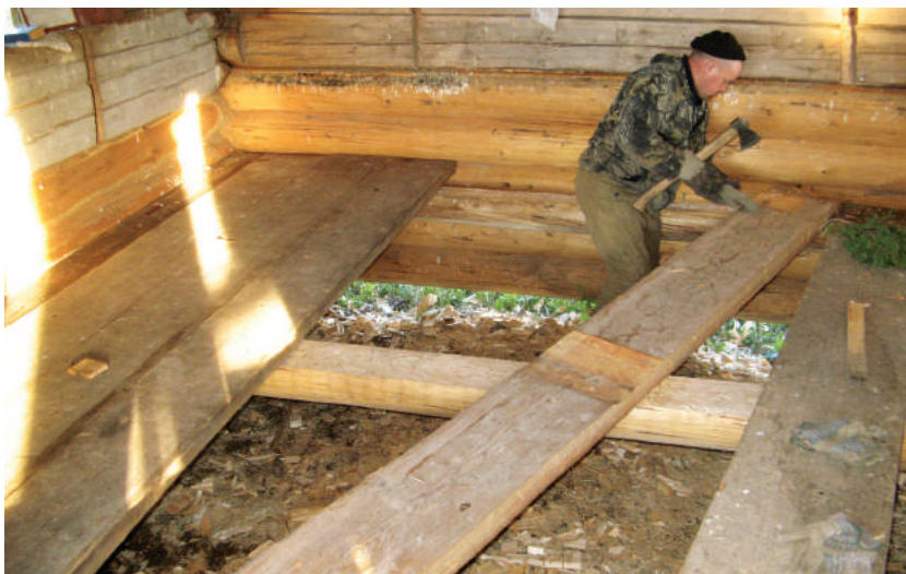
Доски пола укладываются на балку и концами заводятся в пазы-щели в стенах сруба
