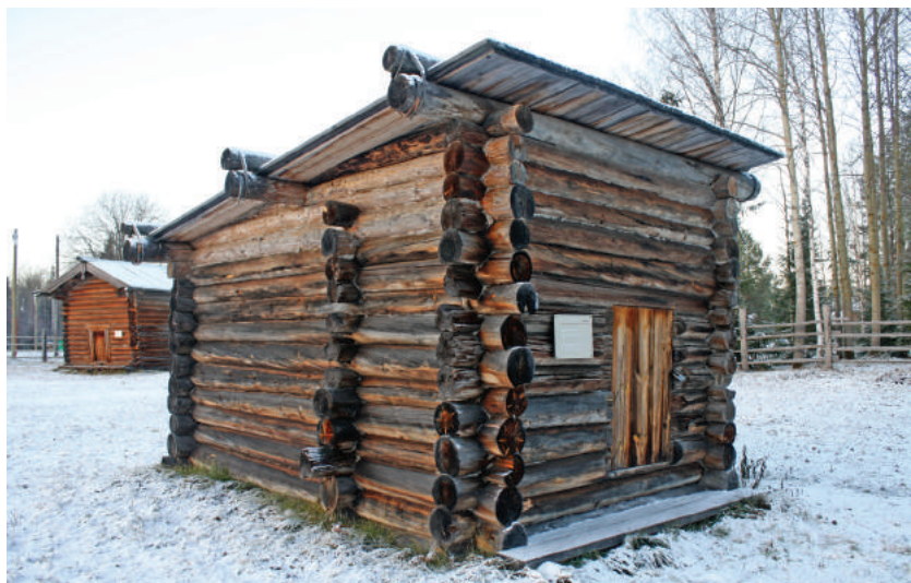
Безгвоздевая односкатная кровля на амбаре в музее «Малые Корелы»
