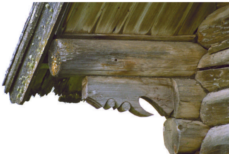
Подкровельный кронштейн дома на Онеге
