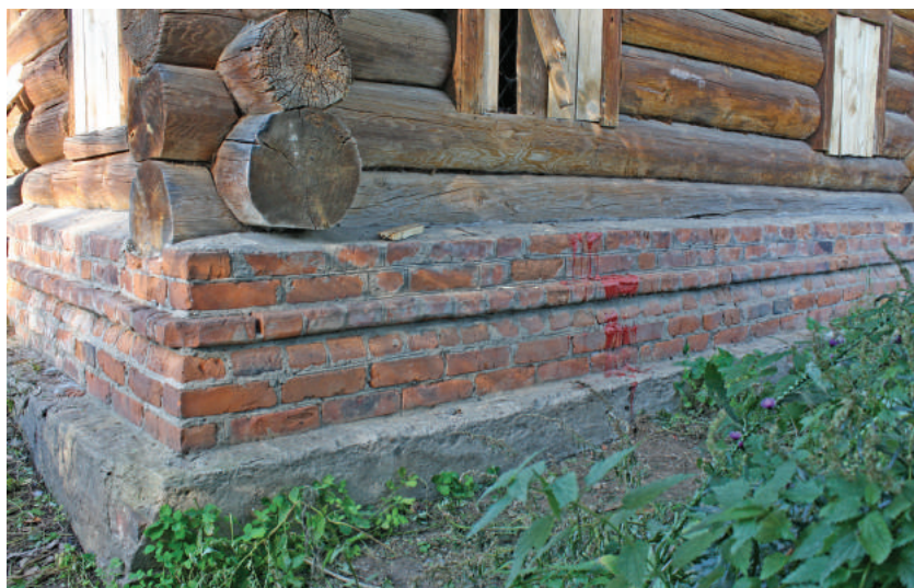
Кирпичный ленточный фундамент. Дом Меховых в Угличе
