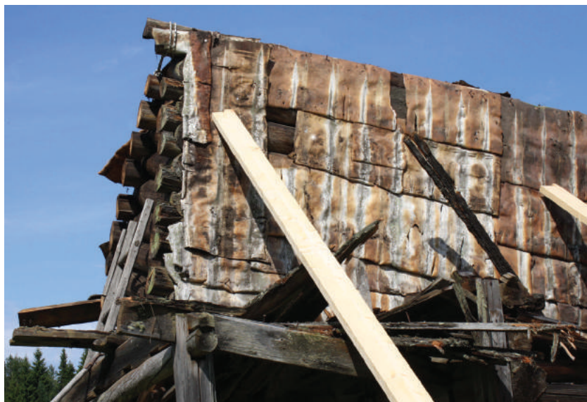
Берестяные маты на кровле. Георгиевская часовня в деревне Ермолинская
