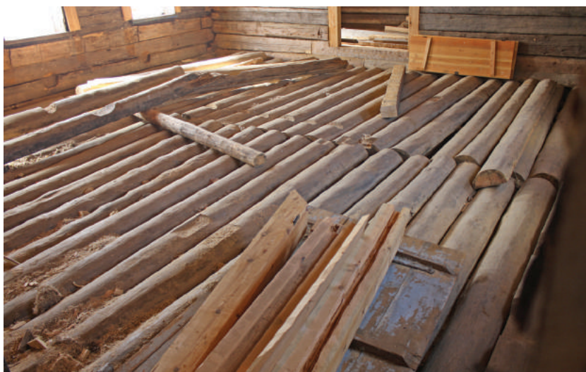
Бревенчатое перекрытие – черновой пол в церкви Почозерского погоста
