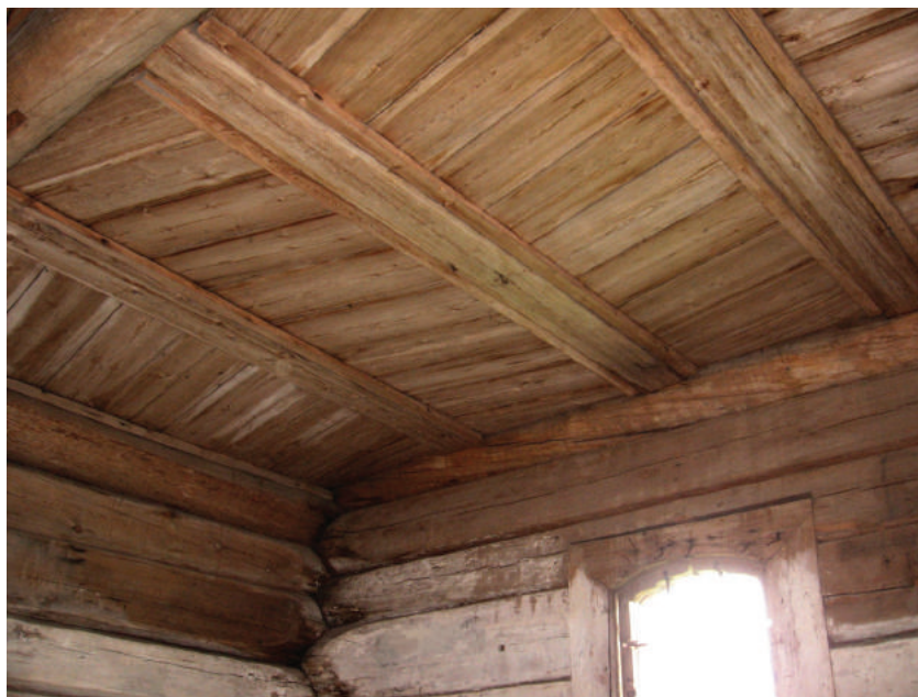
Потолок «в елку» по балкам в Преображенской церкви в деревне Ижма
