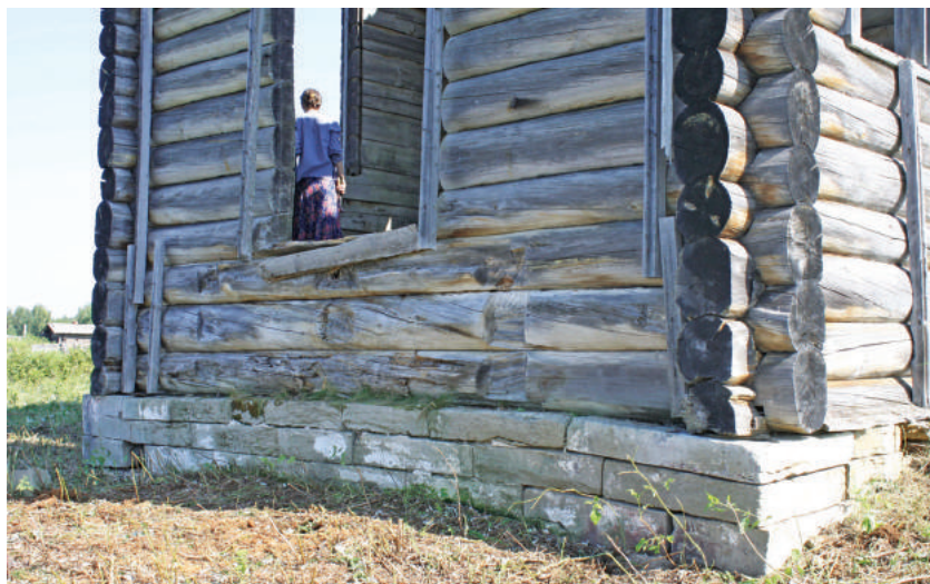
Фундамент из белокаменных плит. Рождественская церковь в селе Кулой
