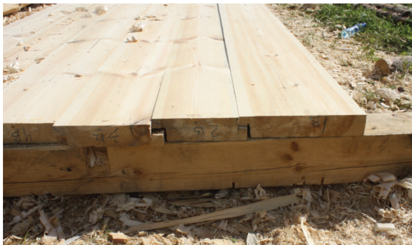
Доски потолка, подготовленные к укладке, имеют соединение в четверть
