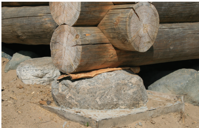
Устройство валунного фундамента на бетонном столбе в современной реставрационной практике
