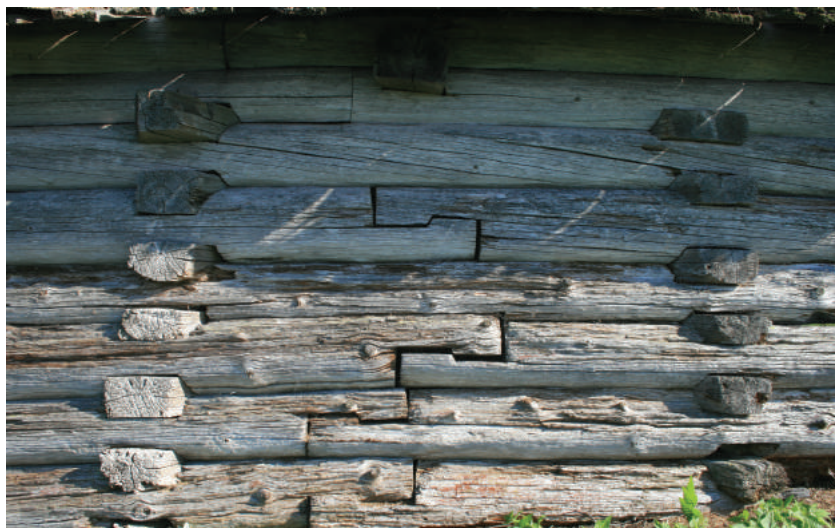
Сращивание брёвен по длине. Ограда Ильинского Водлозерского погоста
