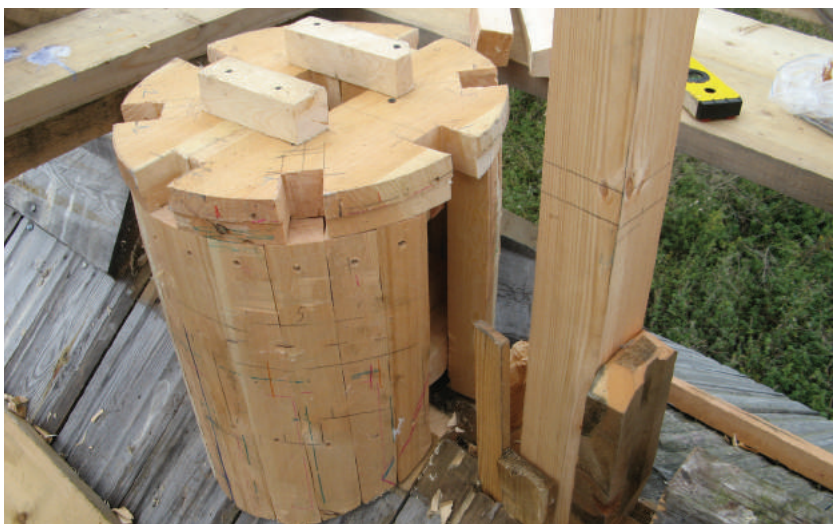
Изготовление и установка главки
