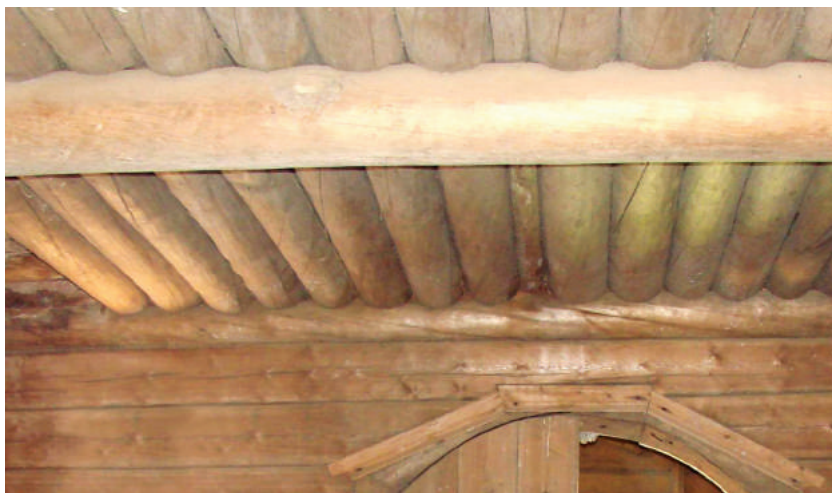
Потолок из бревенчатого наката в притворе Троицкой церкви Соезерской пустыни
