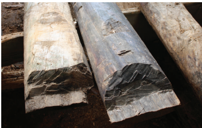
Плахи пола с концами, затесанными для закладки в сруб
