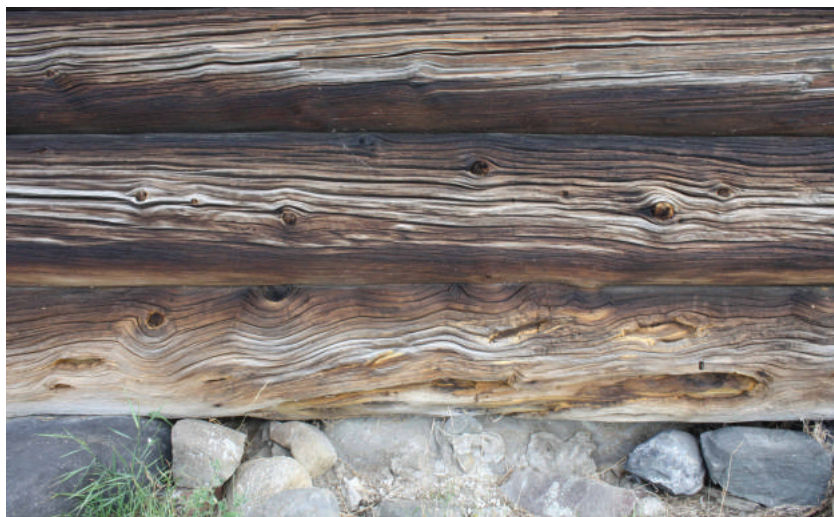
Косослойная древесина (волокна расположены по спирали) сложна в обработке. Такие брёвна, как правило, не распускали, а использовали в виде круглого леса
