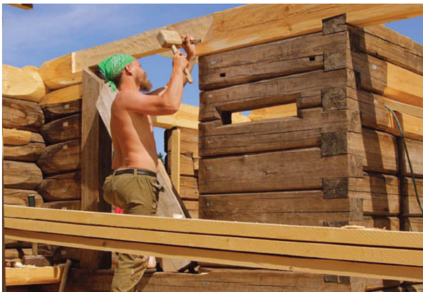
Выборка в бревне под гребень дверного косяка при помощи плоского долота и киянки
