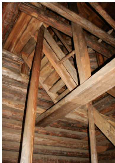
Конструкции внутри сруба колокольни Никольской церкви в деревне Сырья. Видна балка, на которую опирается осевой столб
