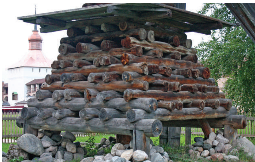
Основание мельницы срубленное «в реж». Мельница из деревни Горка в Кирилло-Белозерском монастыре
