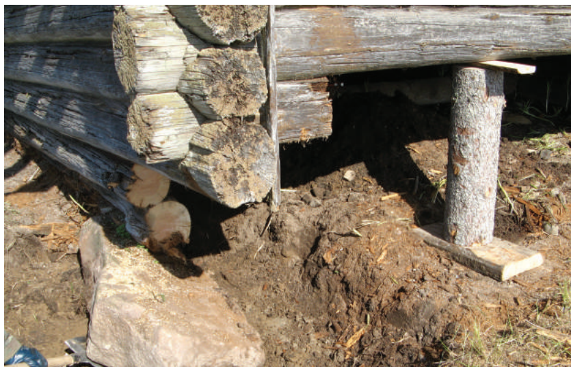
Реставрация валунного фундамента
