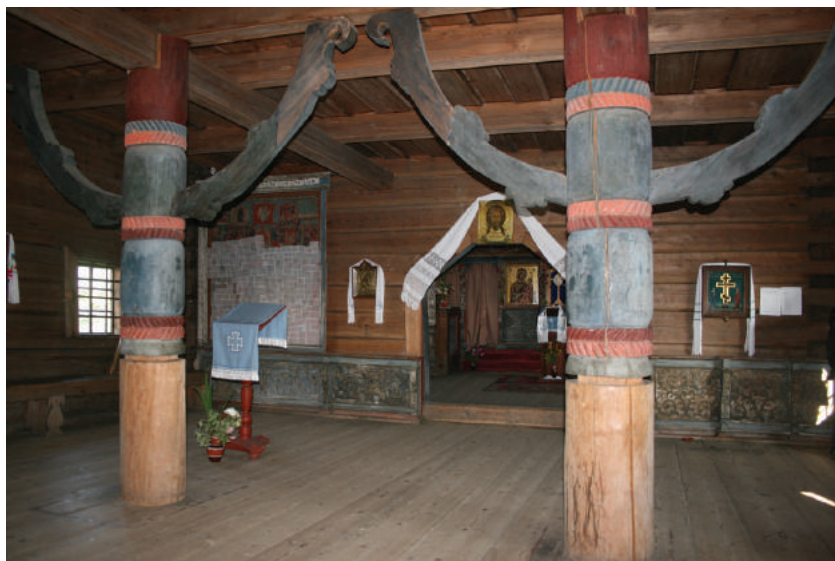
Потолок в трапезной Успенской церкви в Кондопоге подпирают столбы с кронштейнами
