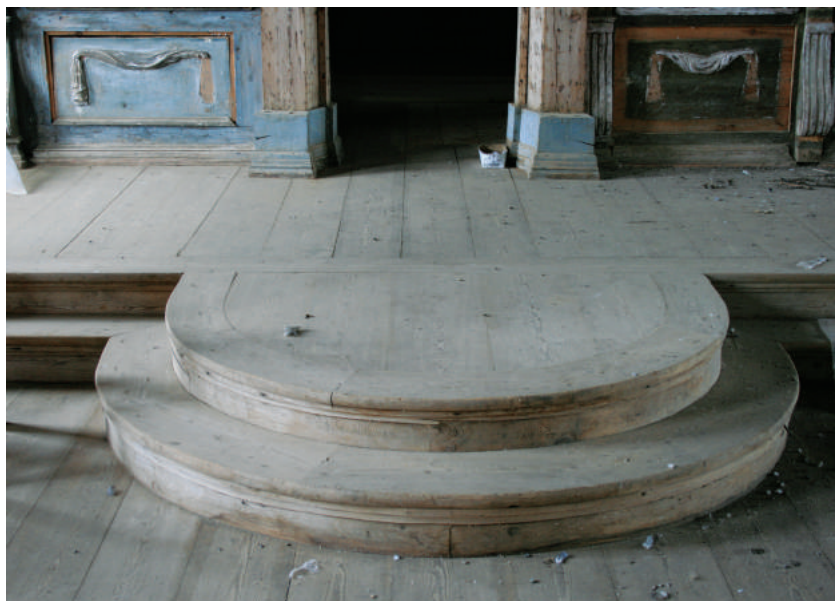
Ступенчатая соleya с амвоном в церкви изготовлена из массивных брусков, сплочённых друг с другом и тщательно отесанных
