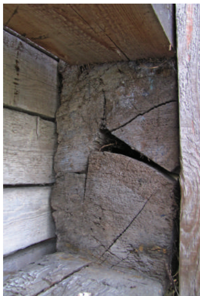
Способ припазовки брёвен с продольным гребнем
