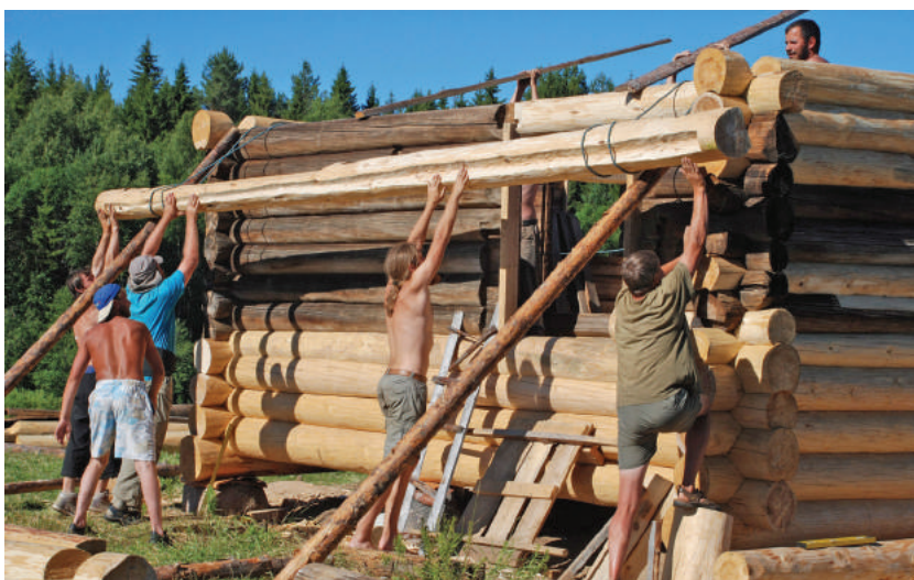
Подъём брёвна на сруб при помощи покатов и верёвок
