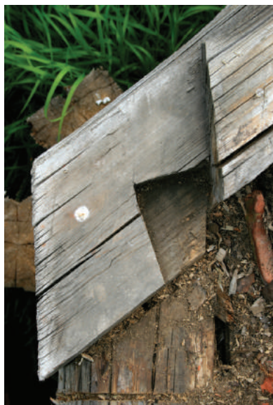
Соединение «в лапу» с потайным шипом
