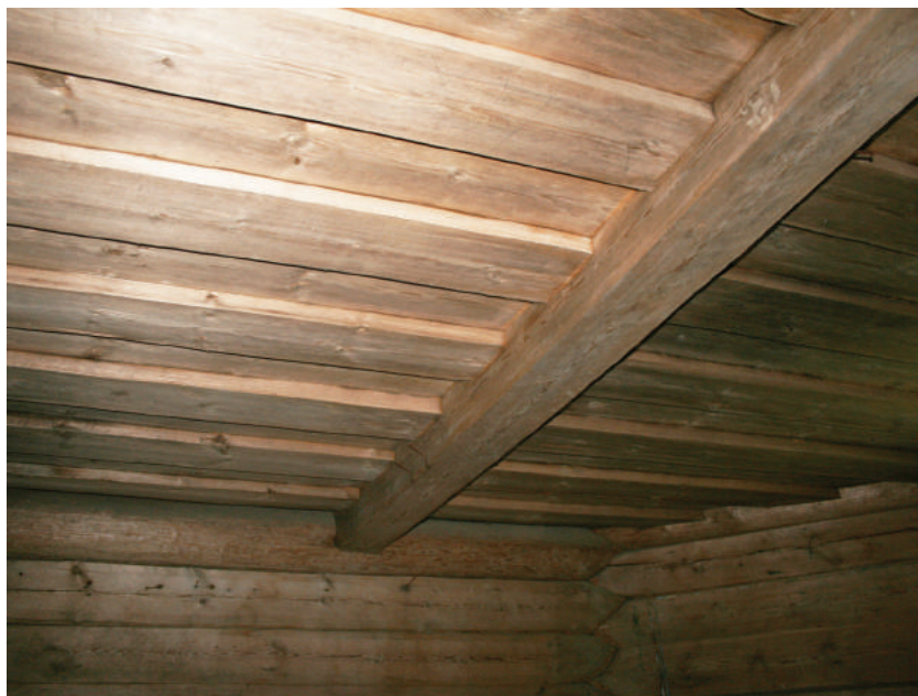
Потолок из досок внахлест по балкам в Благовещенской церкви в деревне Пустынька
