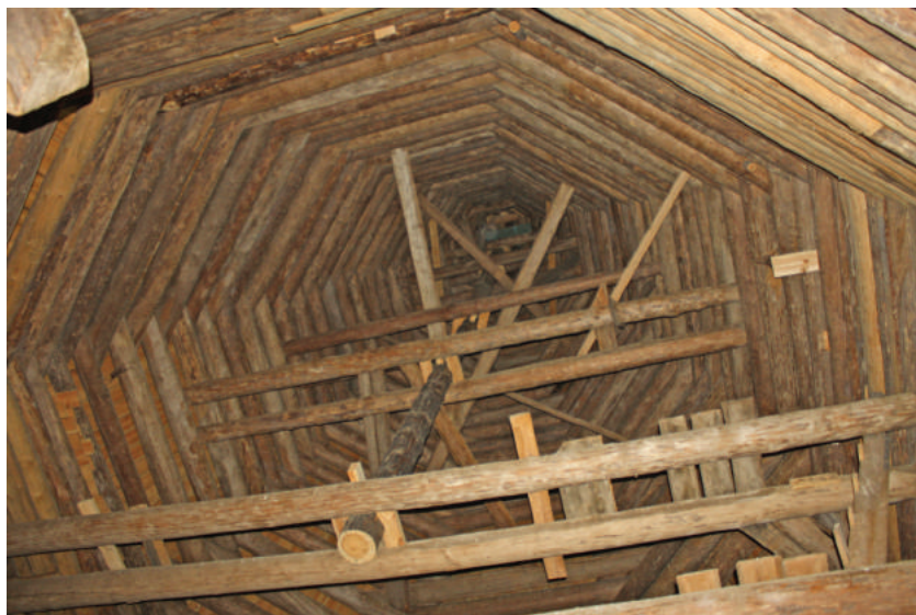
Конструкция рубленого шатра. Церковь Почозерского погоста
