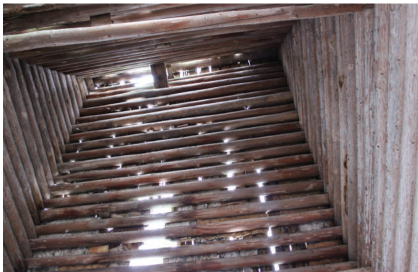
Конструкция двухскатного покрытия. Церковь Козьмы и Дамиана Леждомского погоста
