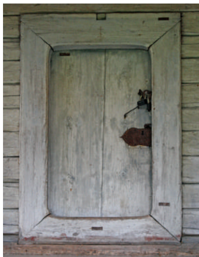
Четырехкосящатое обрамление дверного проема. Церковь Ризоположения из села Бородава
