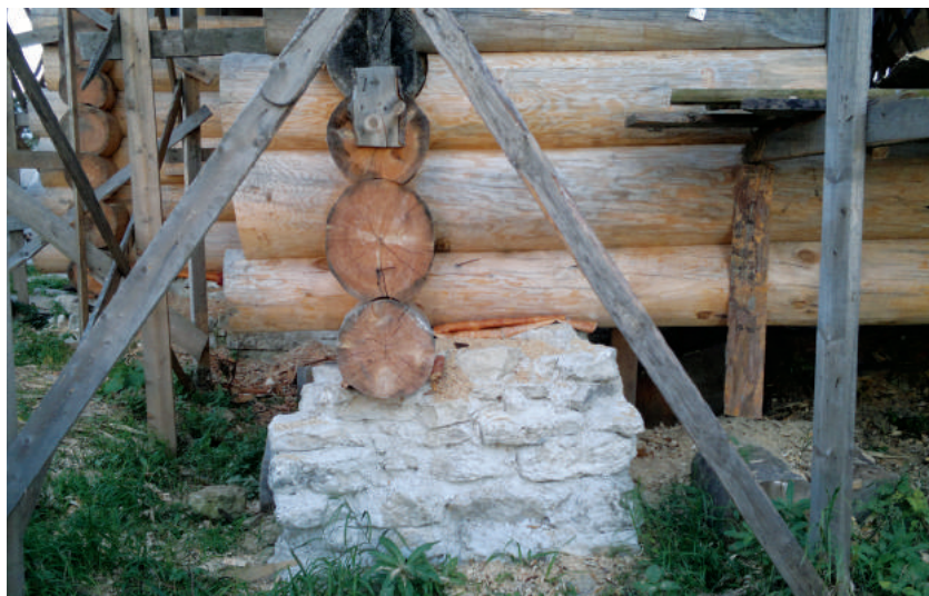
Бутовый столбчатый фундамент. Сретенская церковь в селе Заостровье
