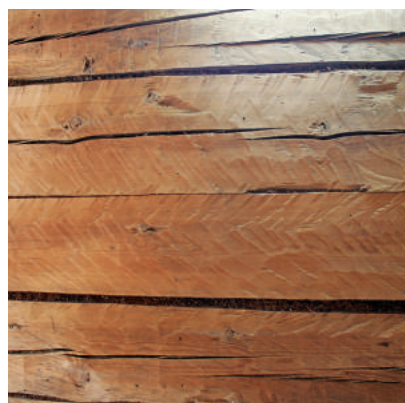
Поверхность стены, обработанная колунообразным топором
