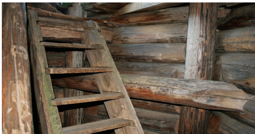
Колокольня в Сырье. Лестница, выходящая на площадку звона. Справа столб, зажатый балками в углу сруба
