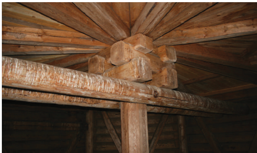
Конструкция, поддерживающая стропила площадки яруса звона. Колокольня в селе Турчасово
