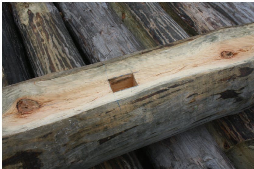
Отверстие под шип
