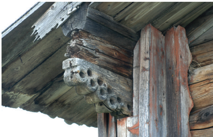
Подкровельный кронштейн дома на Пинеге
