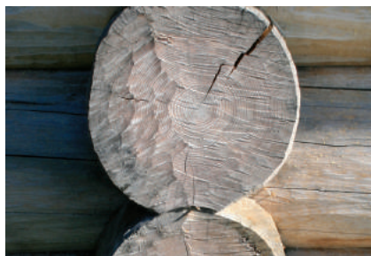
Торец бревна, обработанный топором
