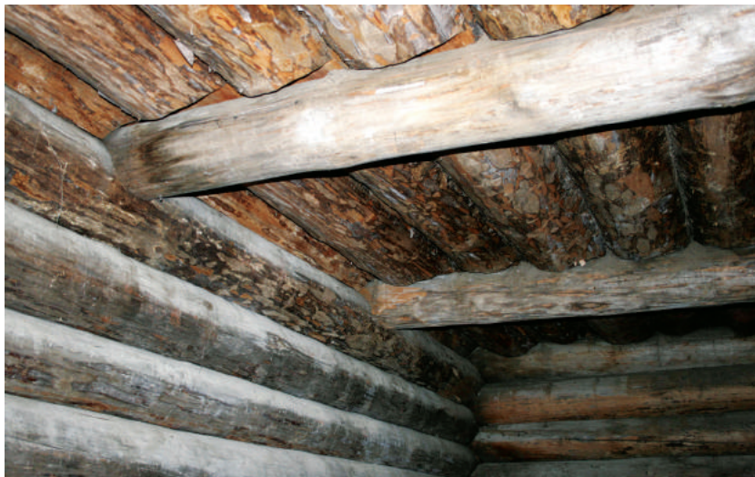
Перекрытие из плах по балкам. Вид снизу
