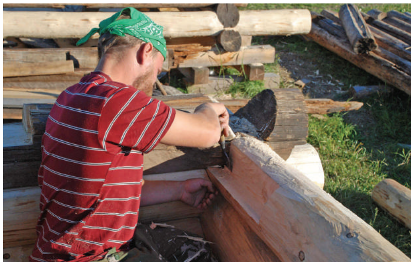
Выборка плоским долотом четверти в бревне
