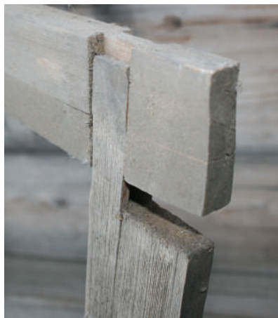
Оконная рама с угловыми соединениями наподобие слюдяных окончин
