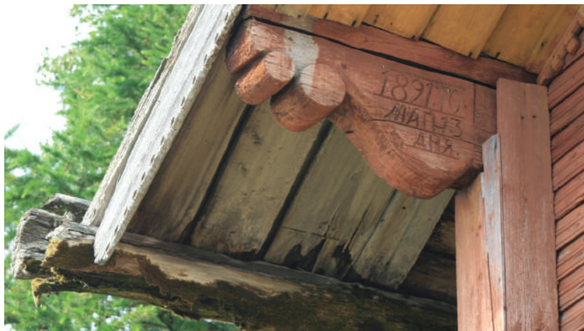
Подкровельный кронштейн дома на Мезени
