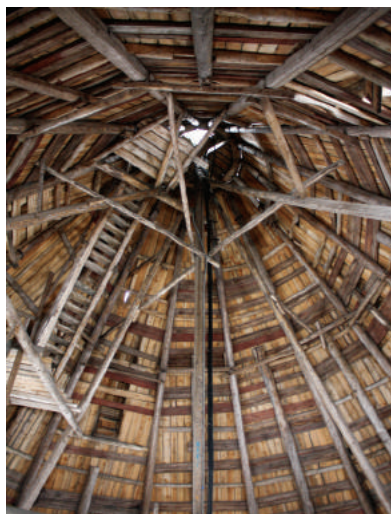
Стропильные конструкции Корожной башни Соловецкого монастыря
