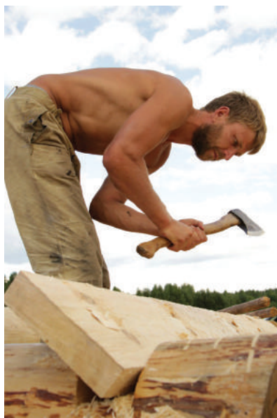
Отёска поверхности колунообразным топором
