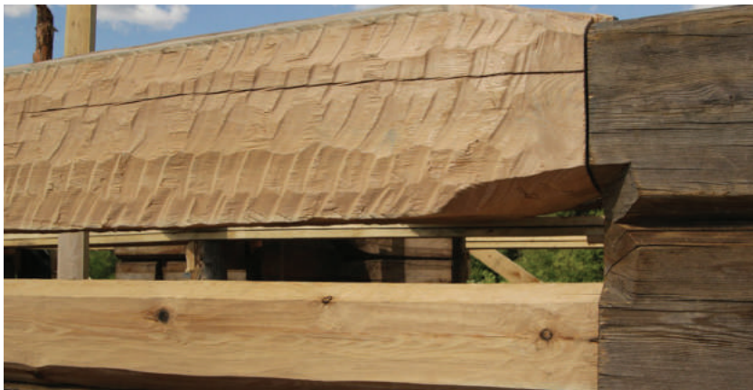
Черновая обработка топором (вверху), чистовая обработка рубанком (внизу)
