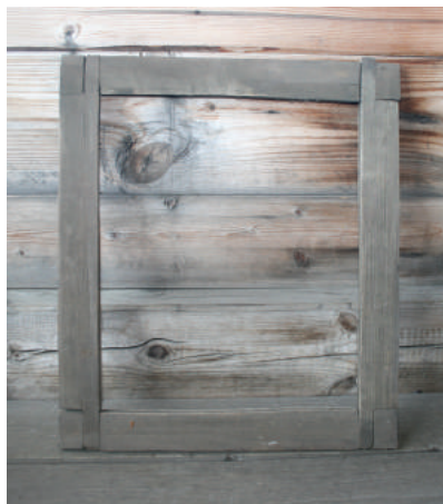
Оконная рама с угловыми соединениями наподобие слюдяных окончин
