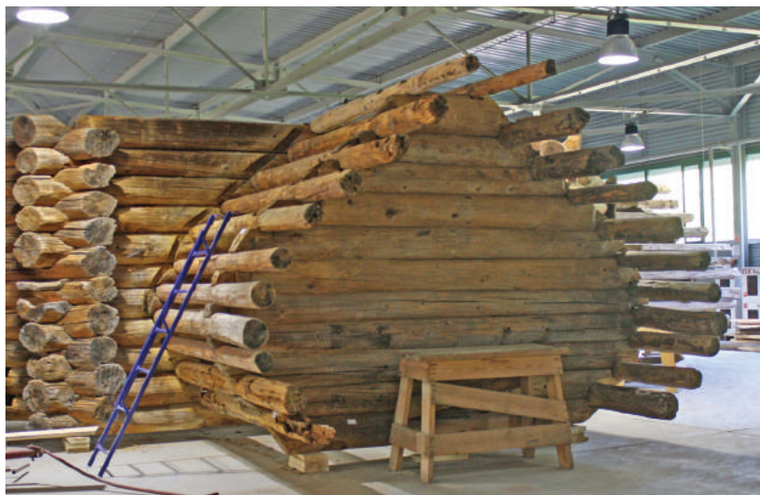
Конструкция бочки. Преображенская церковь в Кижях
