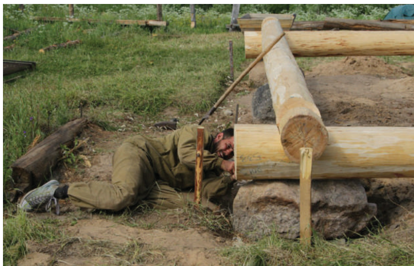
Причерчивание окладного венца под валуны
