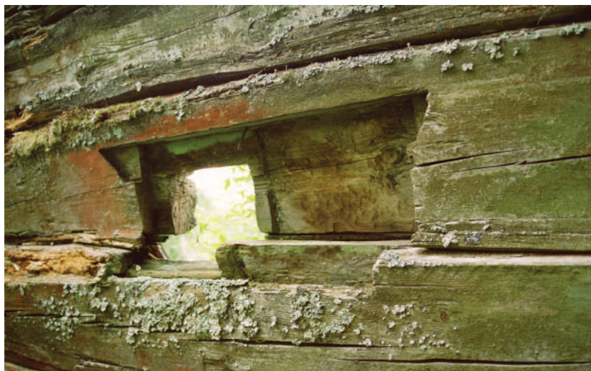
Волоковое окно со следами от задвижки. Вид изнутри
