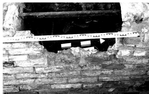
Рис. 4. Ложковая кладка. Фото печи Воскресенского собора
