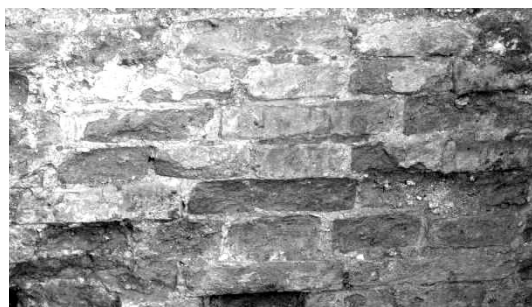
Рис. 3. Полукрестовая кладка. Фото фрагмента стены Воскресенского собора
