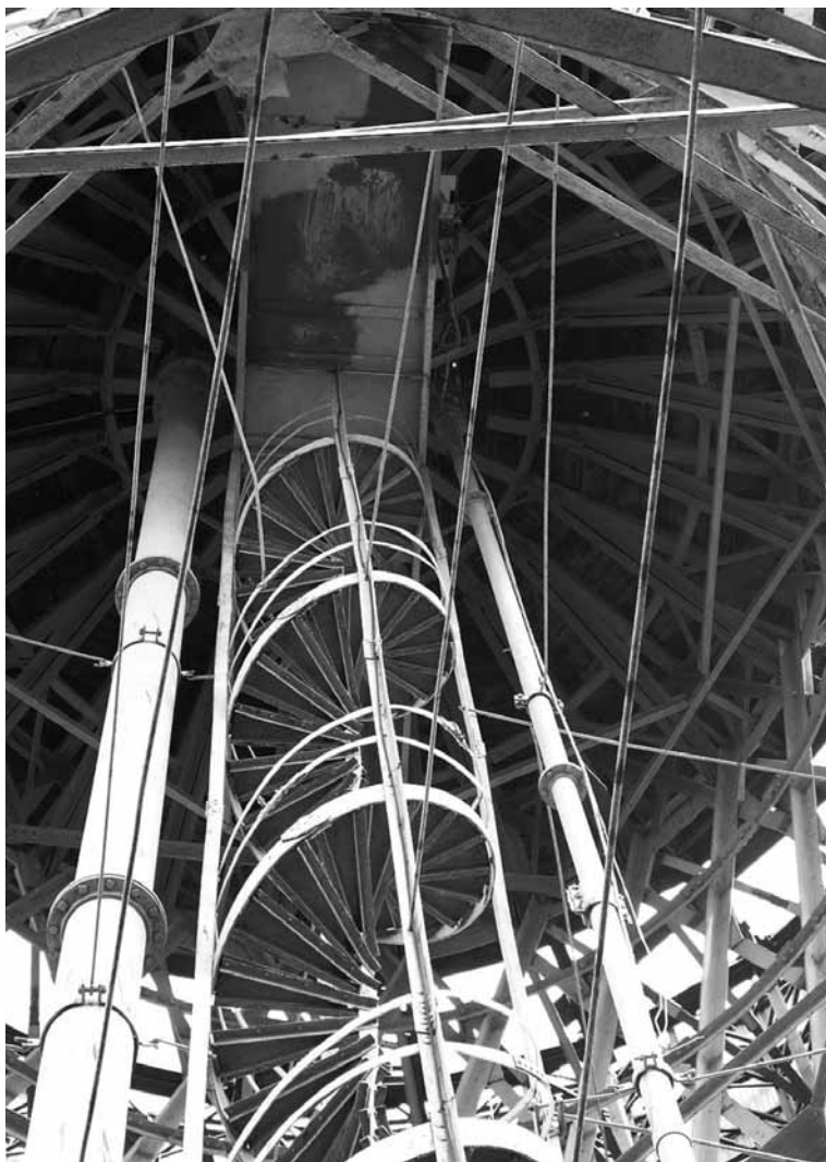
Верхняя часть ствола башни. Винтовая лестница, площадка выхода на галерею, напорная и подающая трубы, система опоры резервуара
