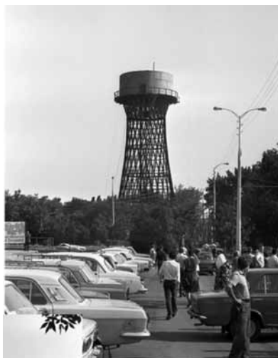
Площадь перед зданием госцирка со стороны ул. им. Шаумяна (ныне – Раипилевская). Северная перспектива. Вид на шуховскую башню. 1986 г. Фото Н. П. Гойдина. Из коллекции Б. Н. Устинова
