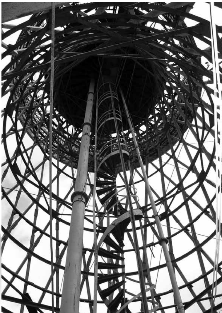
Ствол башни, винтовая лестница, напорная (слева, западная сторона) и подающая (справа, восточная сторона) трубы
