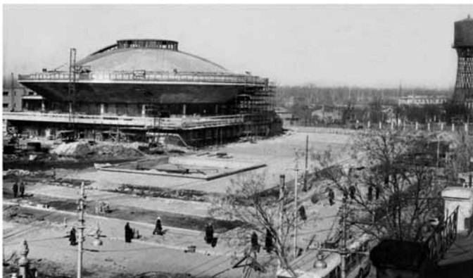
Вид на водонапорную башню и строящийся краснодарский цирк. 1967 г. Фототека ГАКК
