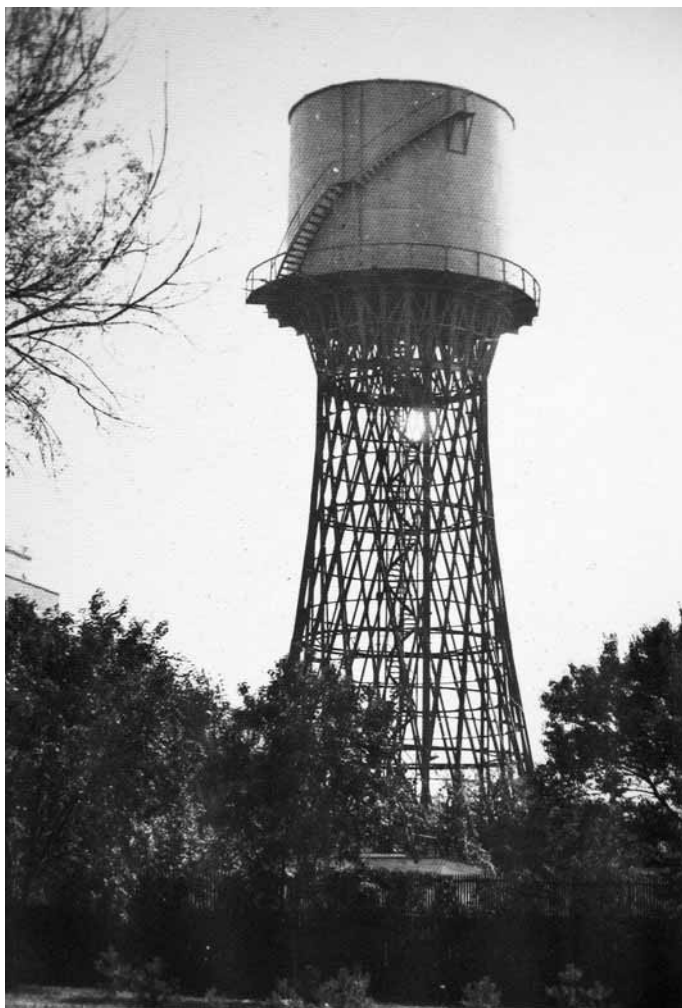
Башня В. Г. Шухова. 1980-е гг. Фототека ГАКК
