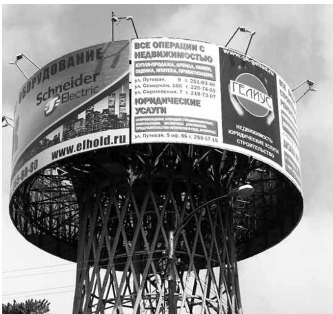
Верхняя часть ствола башни с размещённым на ней вращающимся барабаном
