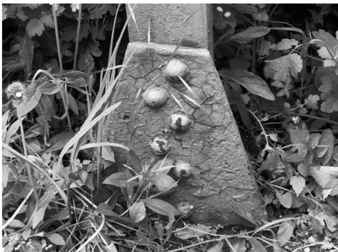
Соединение ноги ствола с опорным кольцом
