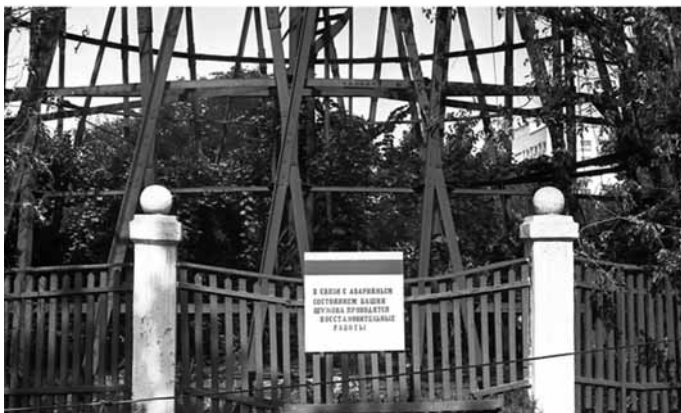
Вид на нижнюю часть башни с улицы им. Шаумяна (ныне – Рашиповская). На ограде – объявление о проводящихся восстановительных работах. 1986 г. Фото В. П. Гойдина. Из коллекции Б. Н. Устинова
