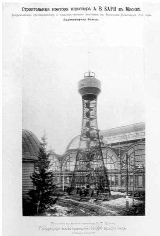
Водонапорная башня системы В. Г. Шухова на Всероссийской выставке в Нижнем Новгороде. 1896 г. 38
