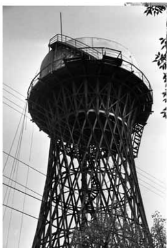
Вид на верхнюю часть башни с частично демонтированным резервуаром. 1986 г. Фото Н. П. Гойдина. Из коллекции Б. Н. Устинова
