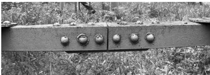
Соединение сегментов горизонтального кольца
