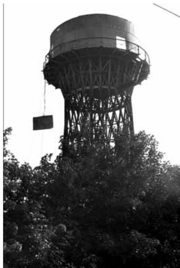
Вид на башню с частично демонтированным резервуаром. 1986 г. Фото Н. П. Гойдина. Из коллекции Б. Н. Устинова
