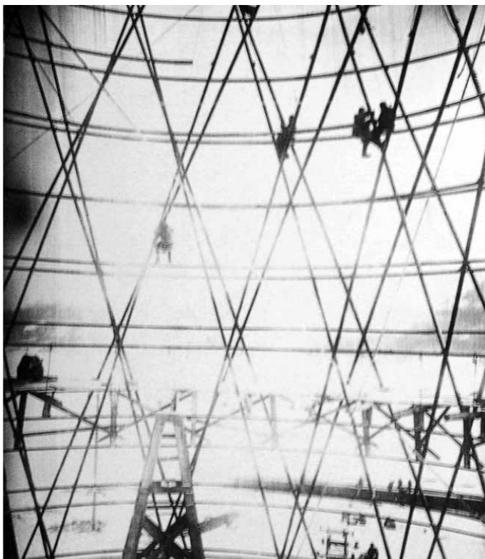
Строительство сетчатой гиперболической башни. Фото 1920-х годов 47
