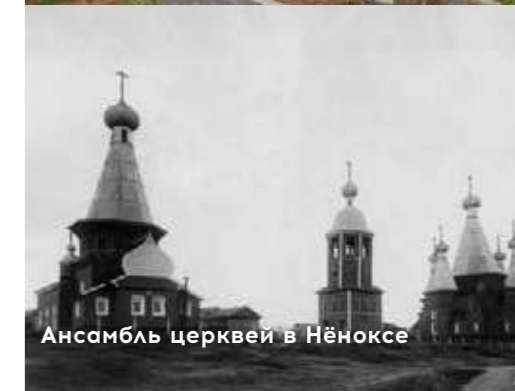
Реставрация Троицкой церкви в Нёноксе
