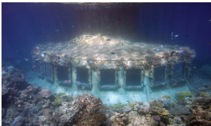
Подводная обсерватория в Эйлате. Вид сооружения с внешней стороны (Источник: http://www.aboutisrael.ru/ris/577/sred/ )
