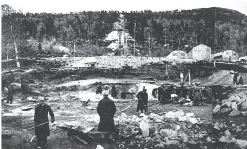
Строительство электростанции лагеря Базис (?).
