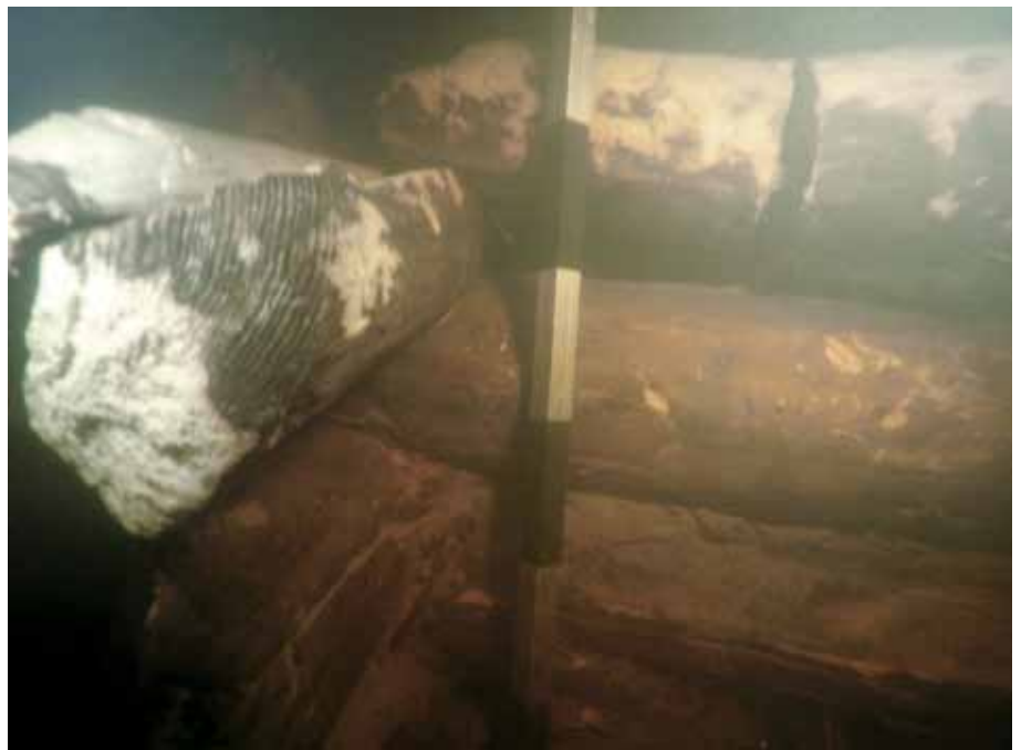
Подводное фото сруба основания опоры моста X века
