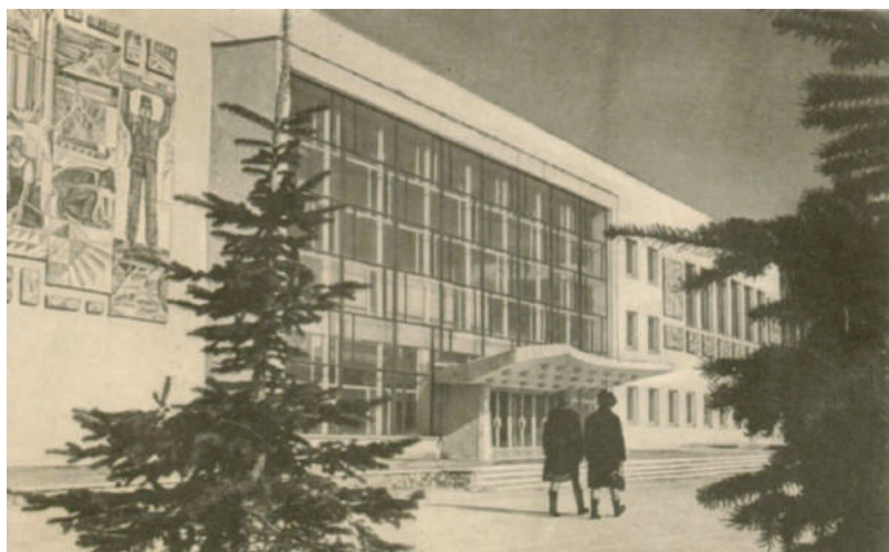
Илл. 6. Дворец культуры «Строитель».
