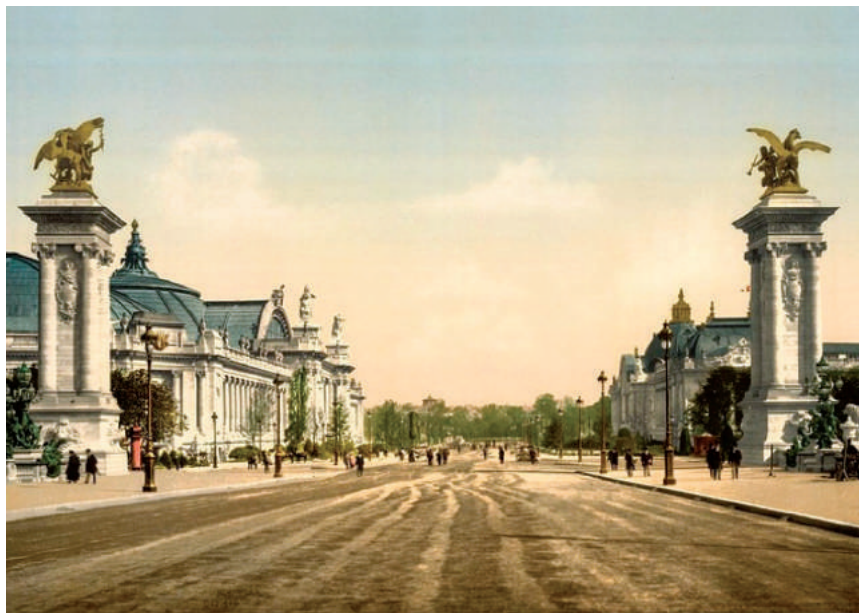
Мост Александра III в Париже. Архитектор Joseph Cassien-Bernard. 1896–1900.
