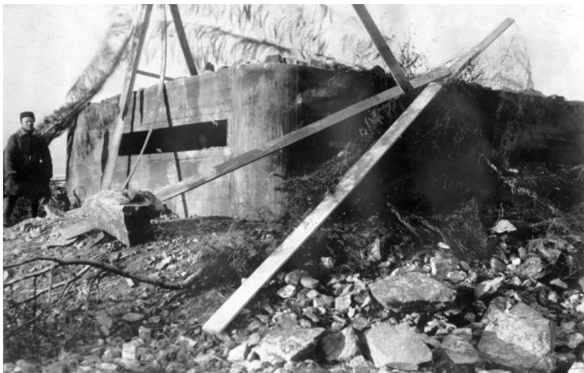
Рис. 24. Бетонированное КП немецкой 210 мм батареи в Лиинахамари
