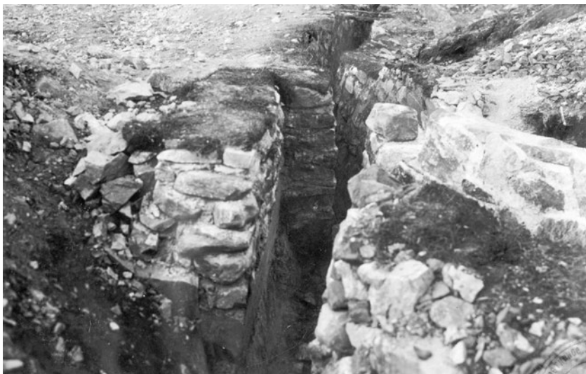
Рис. 27. Немецкая открытая траншея в скальном грунте
