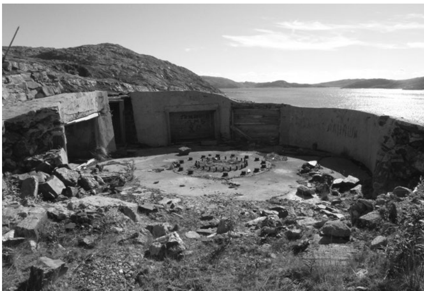
Рис. 58. Разрушенная батарея на входе в Печенгский залив
