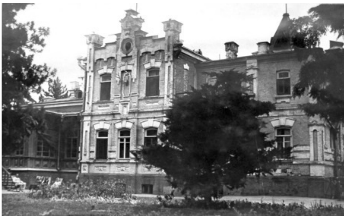
Рис. 4. Вид на северный фасад. Фото 1950–60-х
