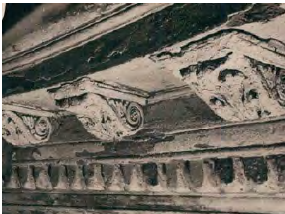
Главный карниз. Модульоны до реставрации. 1957. АМ ДАНЛ
