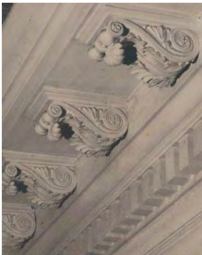
Главный карниз. Модульоны после реставрации. 1957. АМ ДАНЛ
