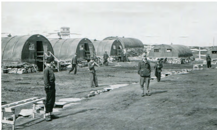
Илл. 1. Лагерь военнопленных в Бьорнелъве, май 1945 г. Фото: ЛейфКрейберг/Госархив
