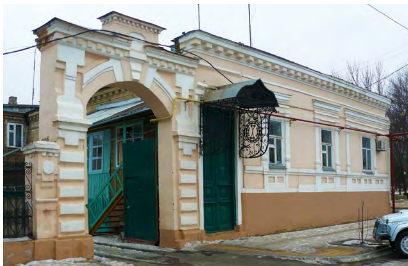
Рис. 5.19. Северо-западный фасад и воротная арка дома М. Н. (?) Луценко на углу улиц им. К. Маркса, 43 и им. Свердлова, 75. Фото В. В. Бондаря, 2010 г.
