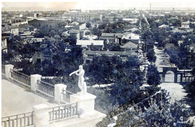
Рис. 5.23. Вид с танцплощадки, устроенной на крыше частично снесенного Михайло-Архангельского собора. Фото 1937 г. Из собрания Ейского историко-краеведческого музея. ЕМ 2358-4.
