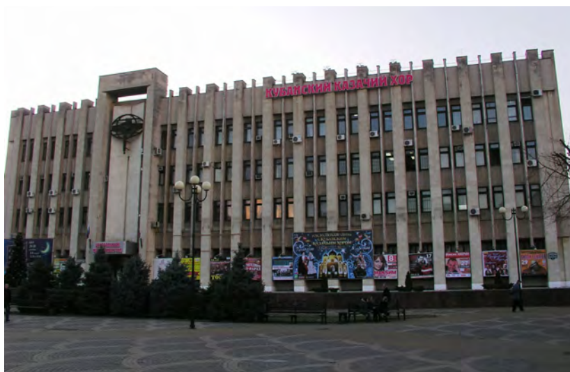
Рис. 1.59. Дом политпросвещения. Фото В. В. Бондаря, 2011 г.
