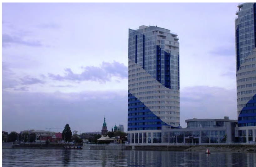
Рис. 1.60. Пример современной диссонирующей застройки. ЖК «Адмирал» на Кубанской набережной. Фото В. В. Бондаря, 2017.
