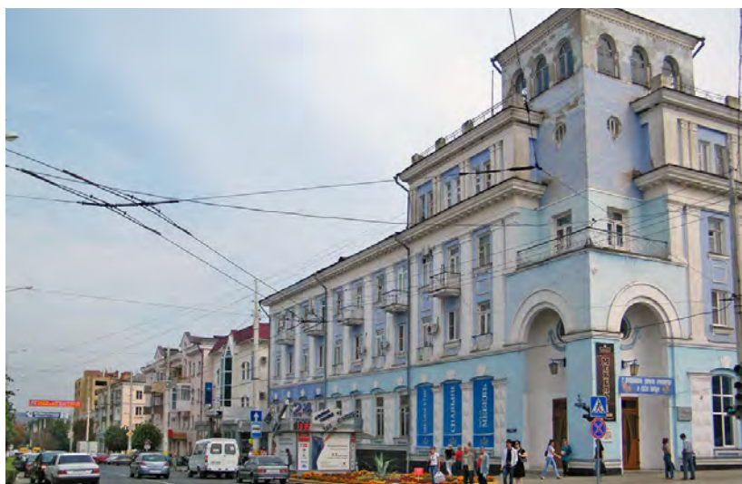
Рис. 4.21. Вид на гостиницу «Северная». 2018 г. Фото из: Проект предмета охраны и границ территории исторического поселения регионального значения город Армавир. Краснодар: АЦ «Югреставрация», 2018 г.
