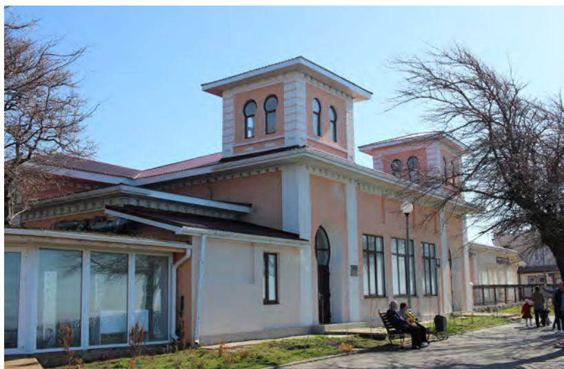
Рис. 3.9. Бывшее здание лечебницы В. А. Будзинского. Фото В. В. Бондаря, 2018 г.
