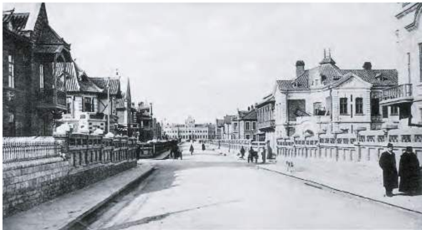
Город Дальний. Инженерный проспект
