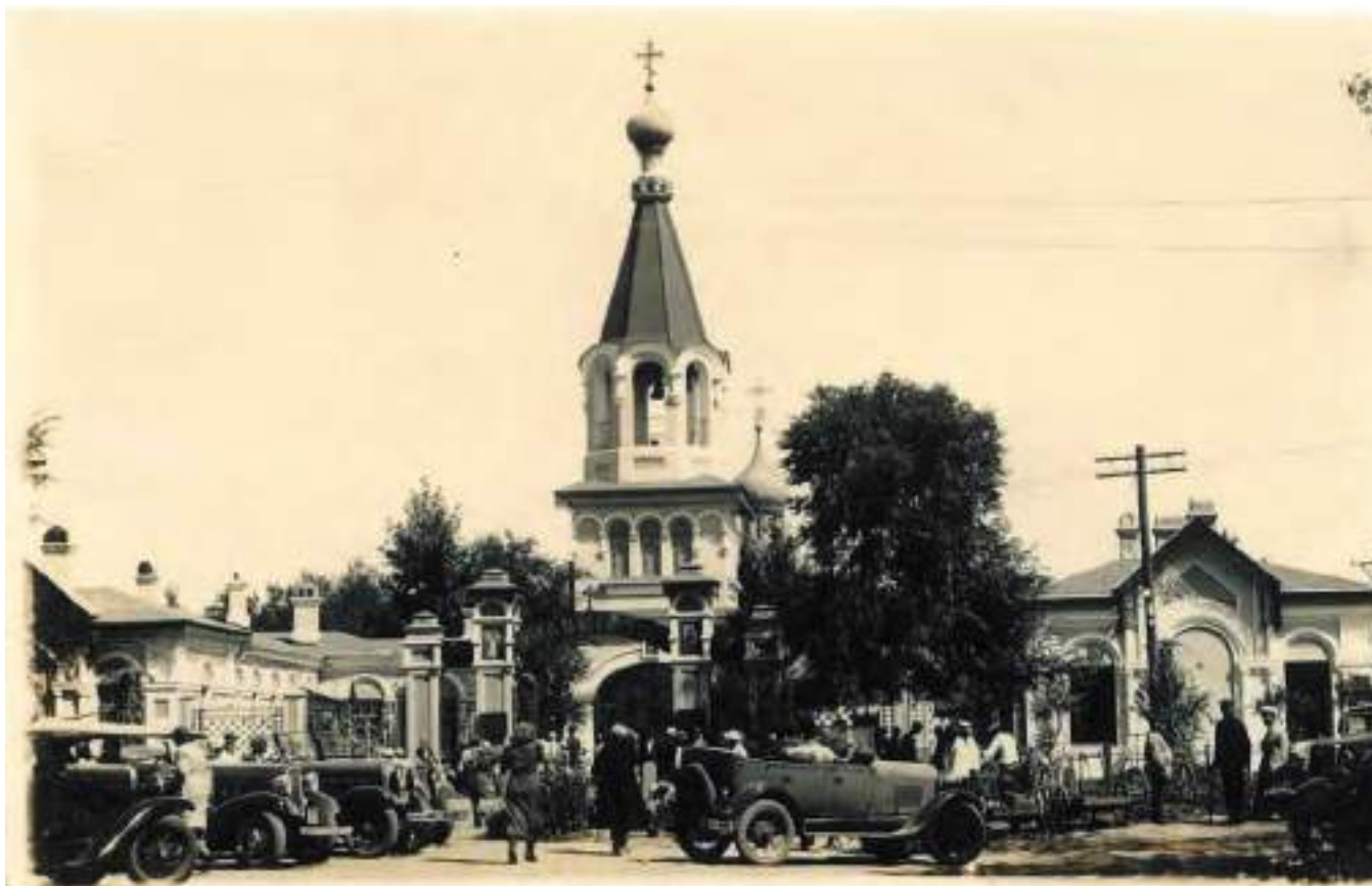
Общий вид колокольни храма
