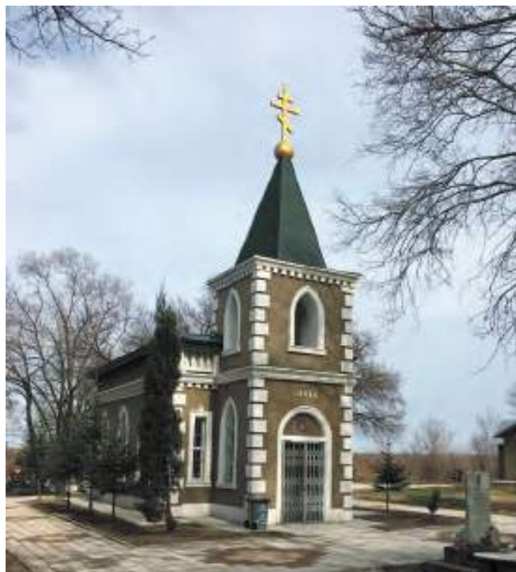
Часовня после ремонта
