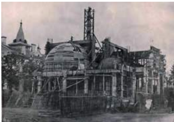
Строительство храма. Фото 1936 г.
