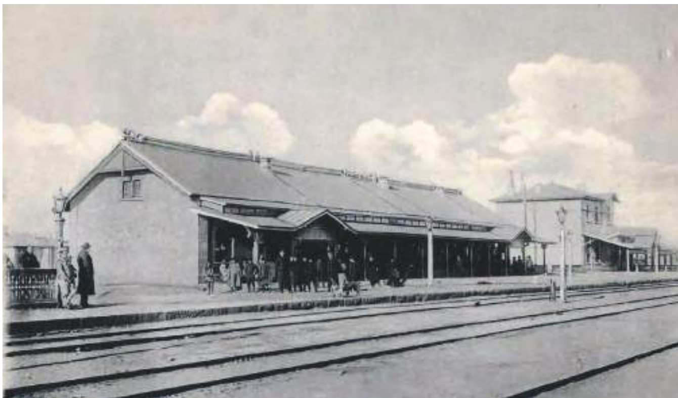
Здание вокзала на станции Хайлар
