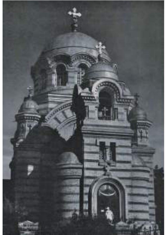
Западный фасад храма
