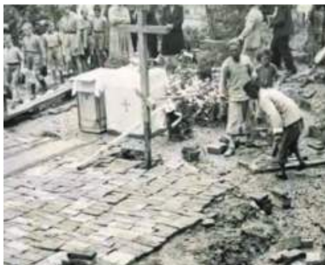
Закладка фундамента храма. Фото 1933 г.
