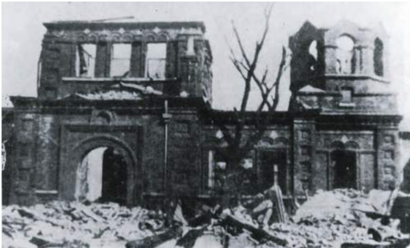
Разрушенное здание храма
