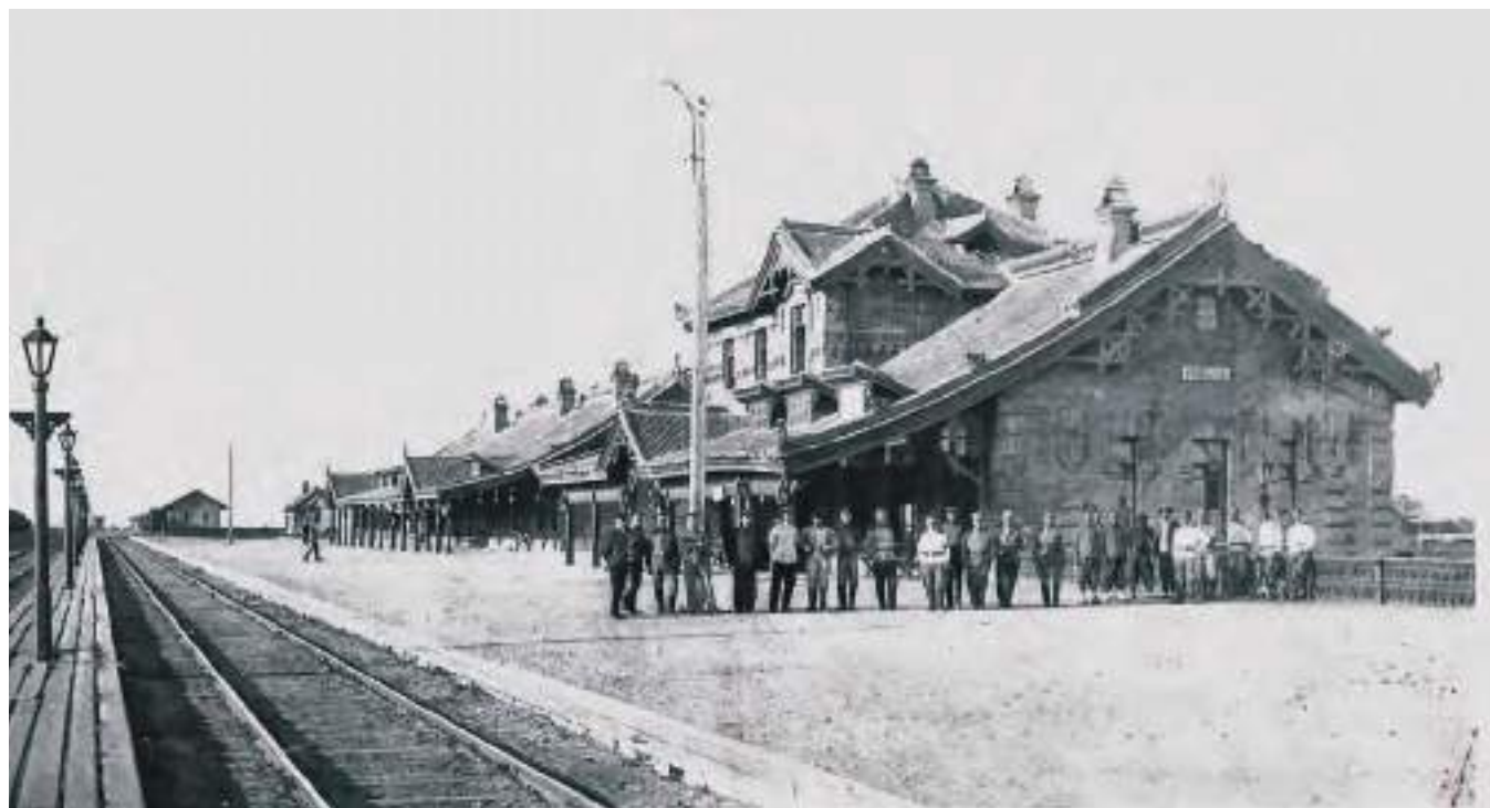
Здание вокзала станции Яомынь
