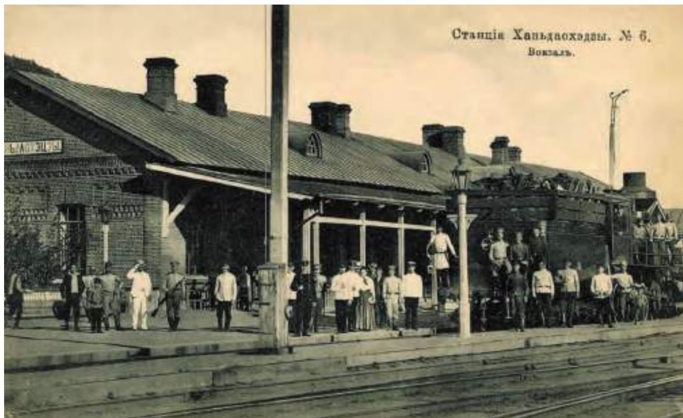
Здание вокзала на станции Ханьдаохэцзы
