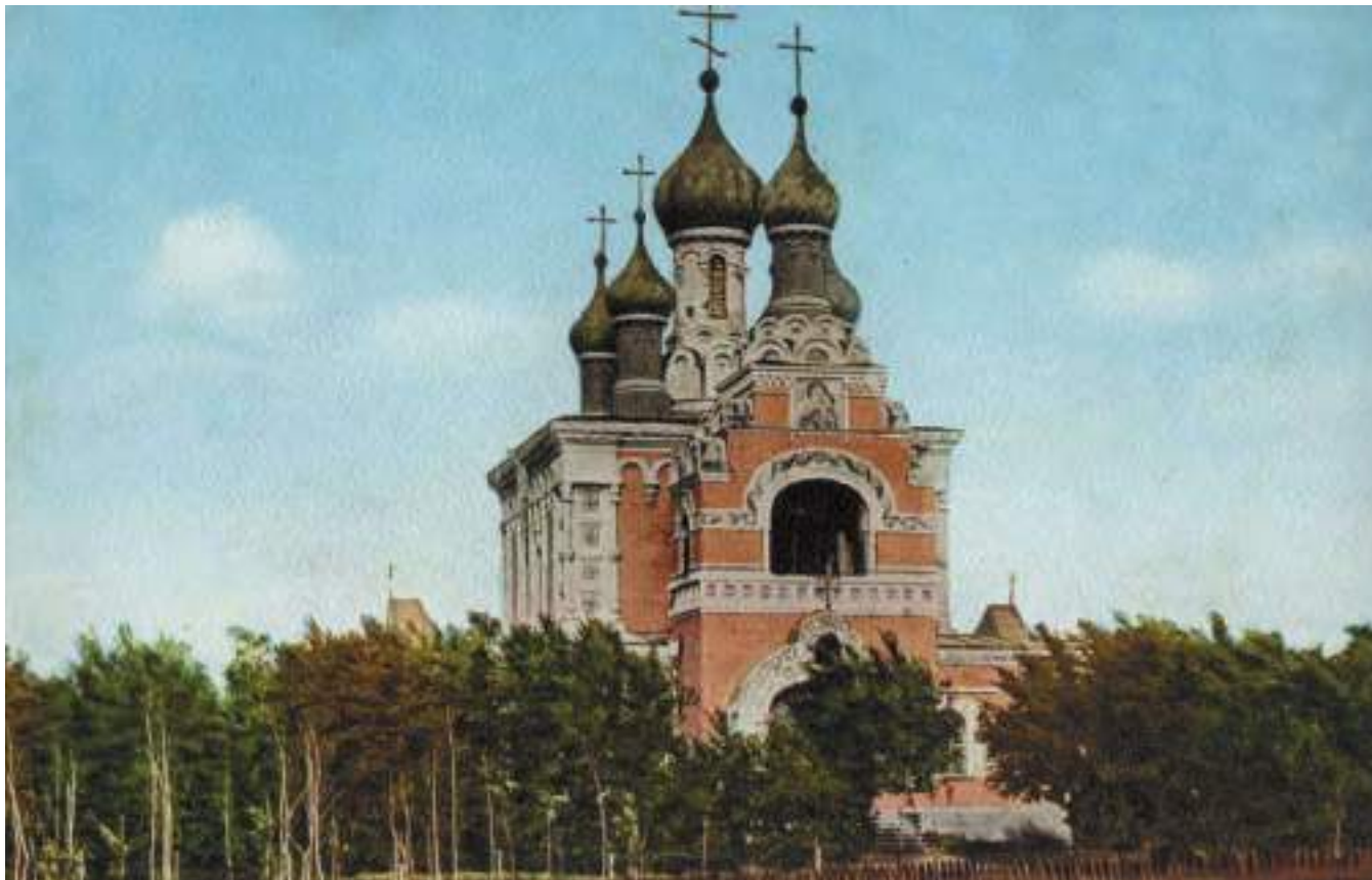
Западный фасад храма
