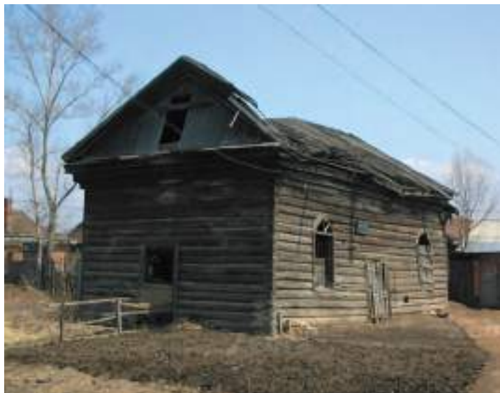
Общий вид церкви до ремонта
