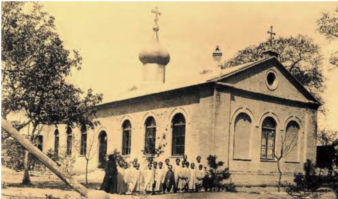
Второе здание храма Успения Божией Матери. Фото 1903 г.
