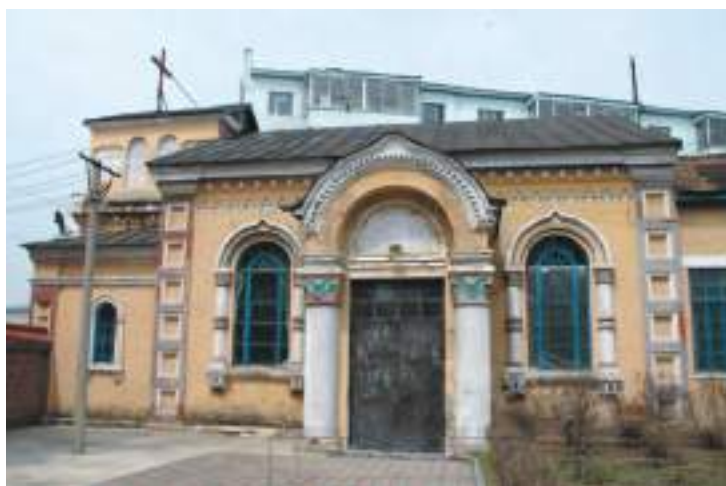
Церковь Николая Чудотворца до ремонта. Фото 2006 г.
