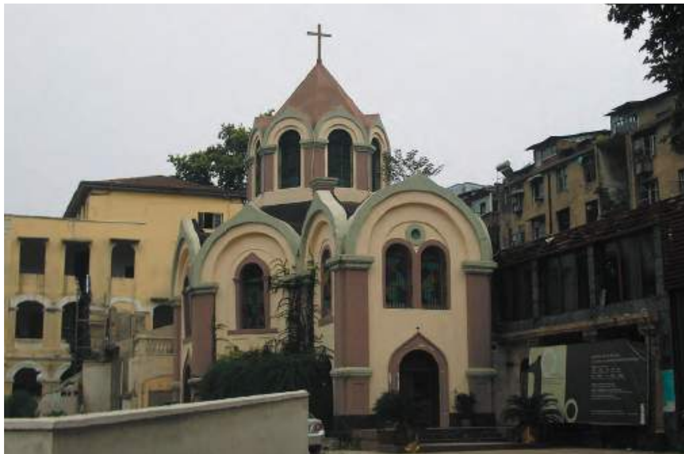
Общий вид храма до реставрации
