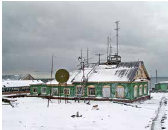
Илл. 407. Старое здание полярной станции «Мыс Челюскин». Вид с вертолета. Фото О. Попова. МАКЭ, 2005 г.
