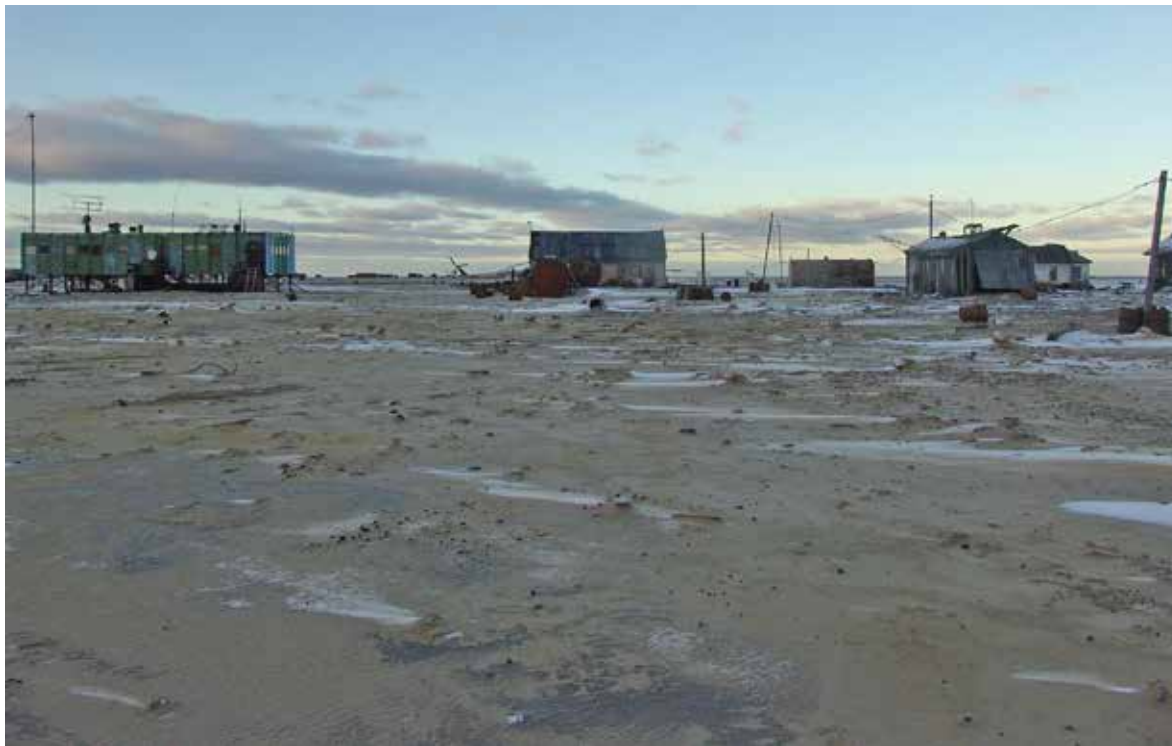
Илл. 176. Постройки полярной станции «Остров Вилькицкого». Фото О. Попова. МАКЭ, 2005 г.
