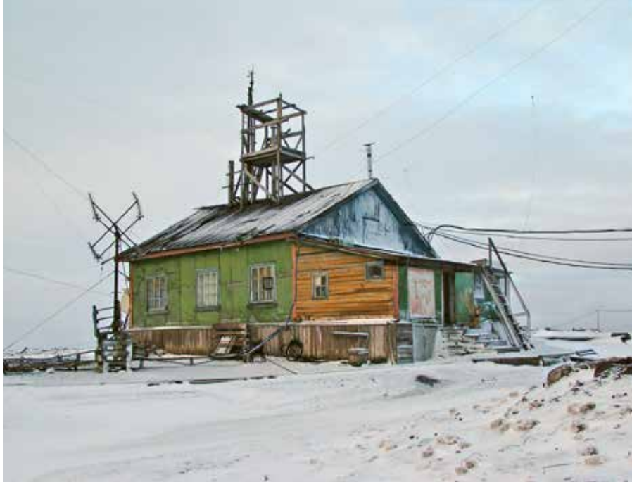
Илл. 402. Здание полярной станции «Остров Визе». Фото О. Попова. МАКЭ, 2005 г.
