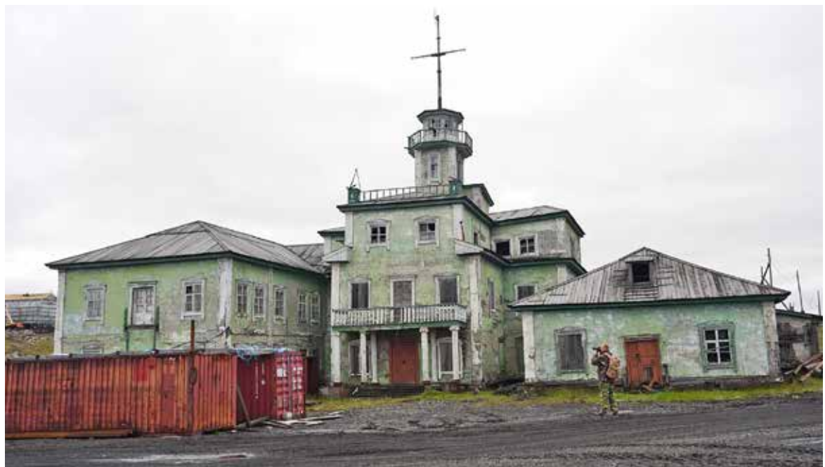
Илл. 151. Здание порта. Фото с запада. Фото П. Филли. МАКЭ, КЭ СФ, 2020 г.
