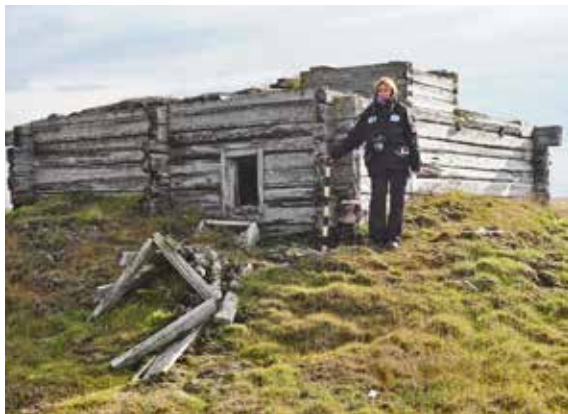
Илл. 280. Вид на дом с юго-запада. Фото П. Филлин. МАКЭ, КЭ СФ, 2020 г.
