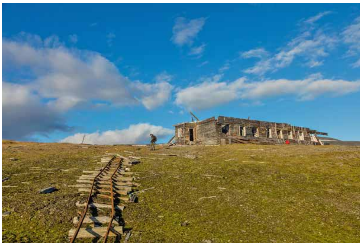
Илл. 32. Восточное устье пролива Маточкин Шар. Руины полярной станции. Фото Н. Гернета, КЭСФ, 2020 г.
