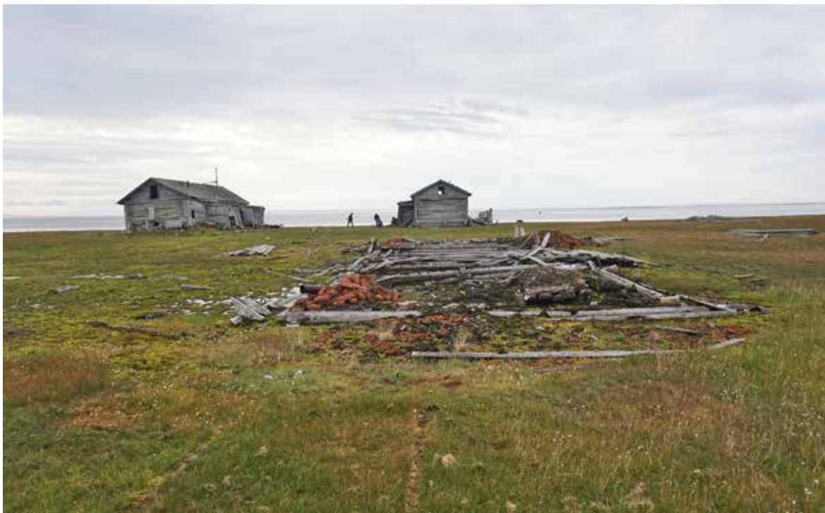
Илл. 312. Промысловый поселок. Вид с северо-востока. Остатки разрушенного дома. Фото П. Филин МАКЭ, КЭ СФ, 2020 г.
