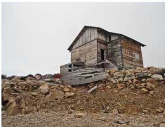
Илл. 27. Размываемый береговой уступ под домом бывшей полярной станции «Мыс Оловянный», основанной Э. Т. Кренкелем в 1935 г. Фото Ф. А. Романенко, 2019
