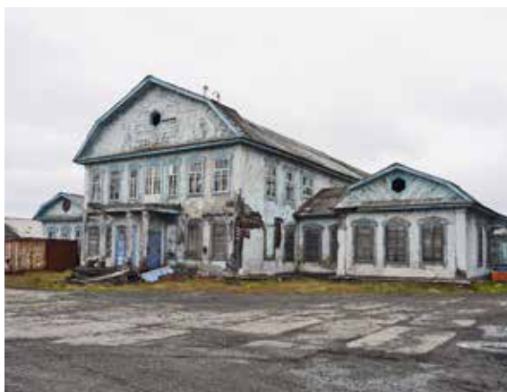
Илл. 163. Фасад здания Торгмортранса. Фото П. Филин. МАКЭ, КЭ СФ, 2020 г.
