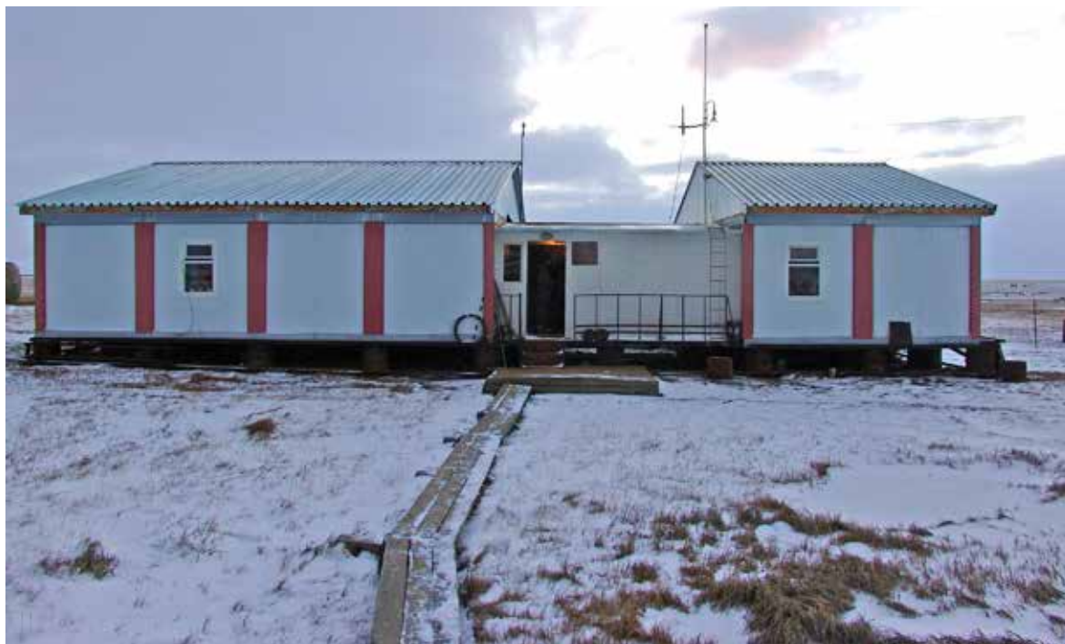
Илл. 64. Новое здание полярной станции «Остров Белый». Фото О. Попова. МАКЭ, 2005 г.
