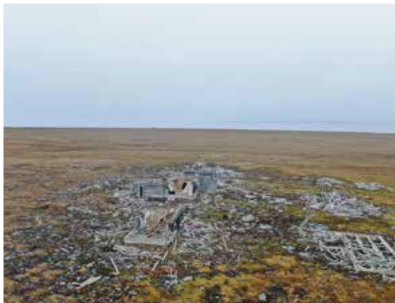
Илл. 352. Вид на жилой комплекс с запада. Фото Р. Жостков. КЭ СФ, 2020 г.
