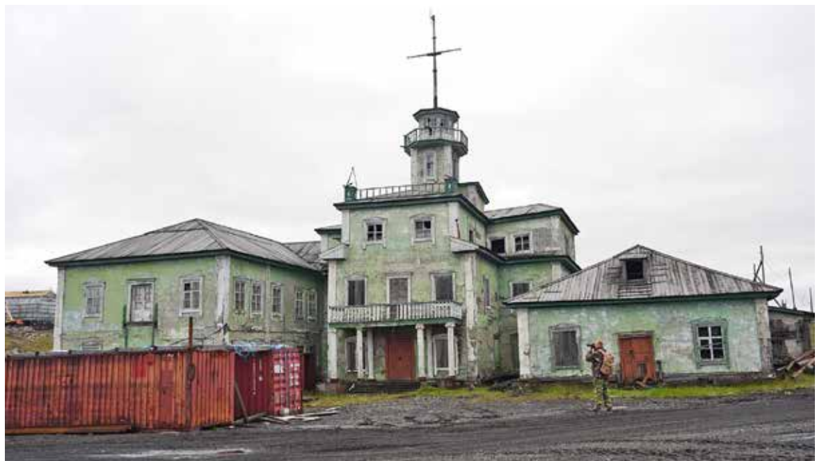
Илл. 151. Здание порта. Фото с запада. Фото П. Филлин. МАКЭ, КЭ СФ, 2020 г.
