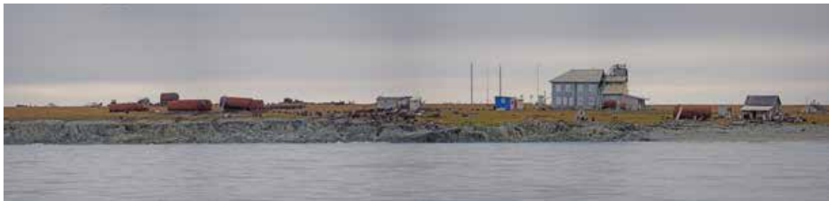
Илл. 215. Полярная станция «Мыс Стерлегова». Фотопанорама, вид с моря. Фото П. Филлин. МАКЭ, КЭ СФ, 2020 г.
