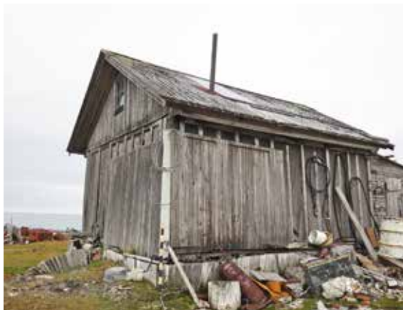
Илл. 206. Баня. Вид с юга. Фото В. Мокштад. КЭ СФ, 2020 г.
