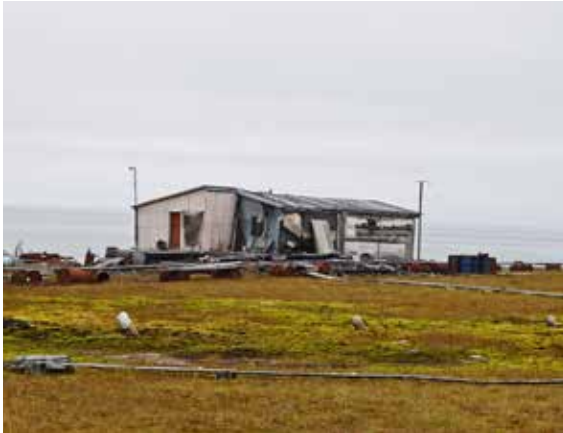
Илл. 210. Здание современной ДЭС. Вид с юга. Фото П. Филин. МАКЭ, КЭ СФ, 2020 г.
