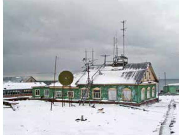
Илл. 407. Старое здание полярной станции «Мыс Челюскин». Вид с вертолета. Фото О. Попова. МАКЭ, 2005 г.
