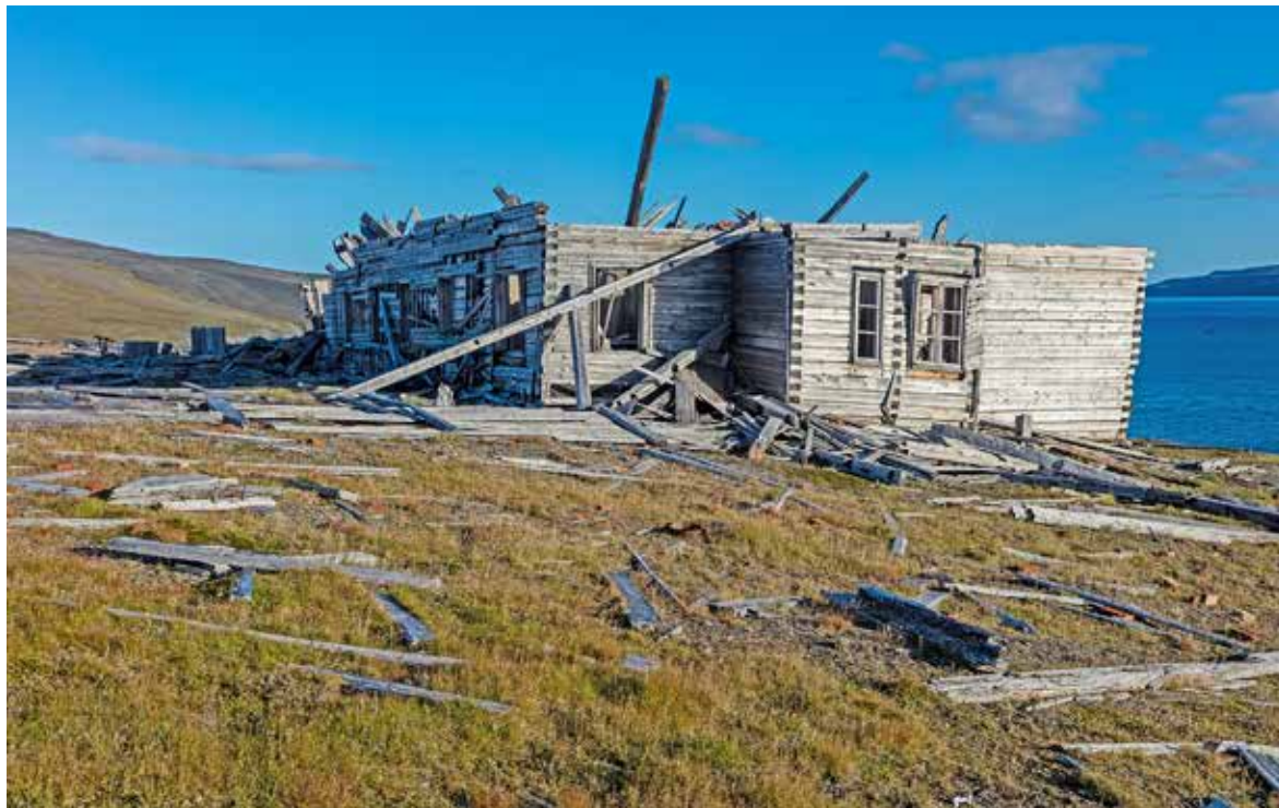
Илл. 33. Восточное устье пролива Маточкин Шар. Руины полярной станции. Фото Н. Гернета, КЭСФ, 2020 г.
