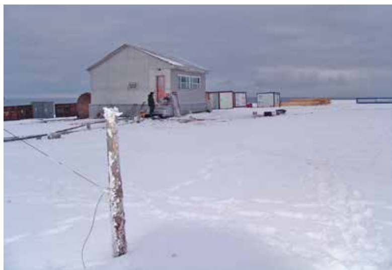
Илл. 425. Постройки полярной станции «Остров Андрея». Фото Н. А. Кузнецова. МАКЭ, 2010 г.
