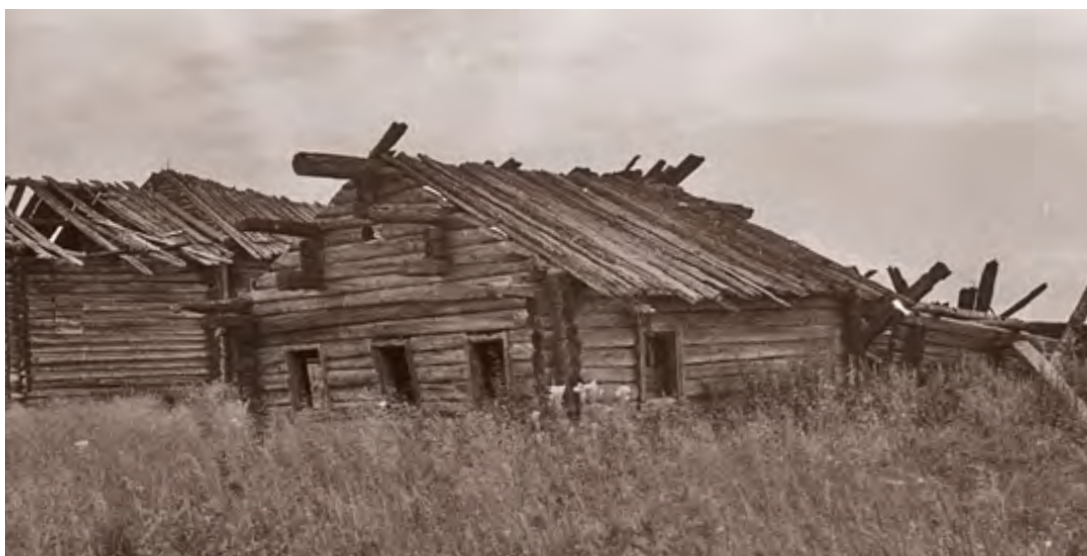
Рис. 2. Дом в деревне Хлевнаволоок Пряжинского района. Музей-заповедник «Кижы». НВФ-9539
