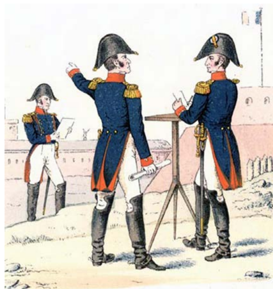
Рис. 3. Инженеры-географы выполняют съемку местности с помощью мензулы
