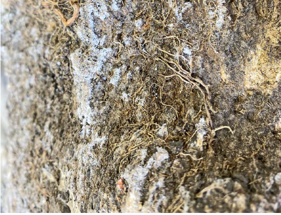
6. Плотный слой почвенных и биологических загрязнений
