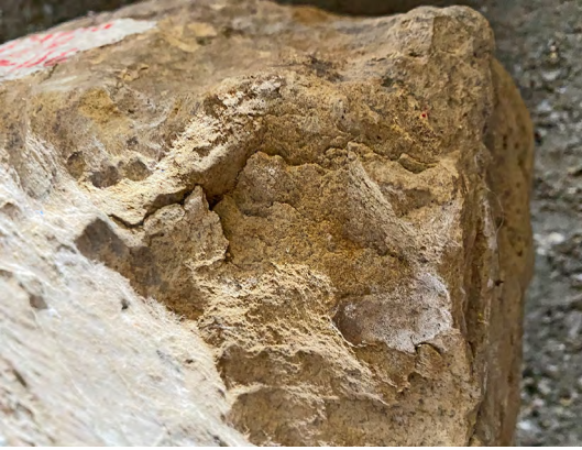
6. Растрескивание, осыпи поверхности
