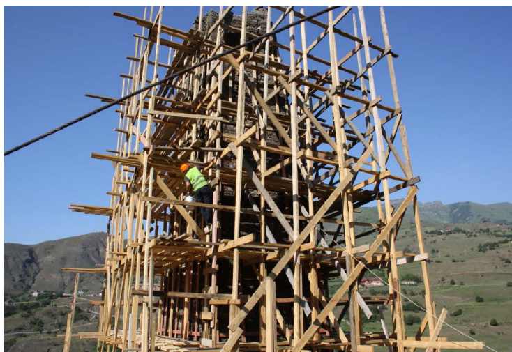
Рис. 3. Реставрационные работы на сторожевой башне. Июль 2021 г.
