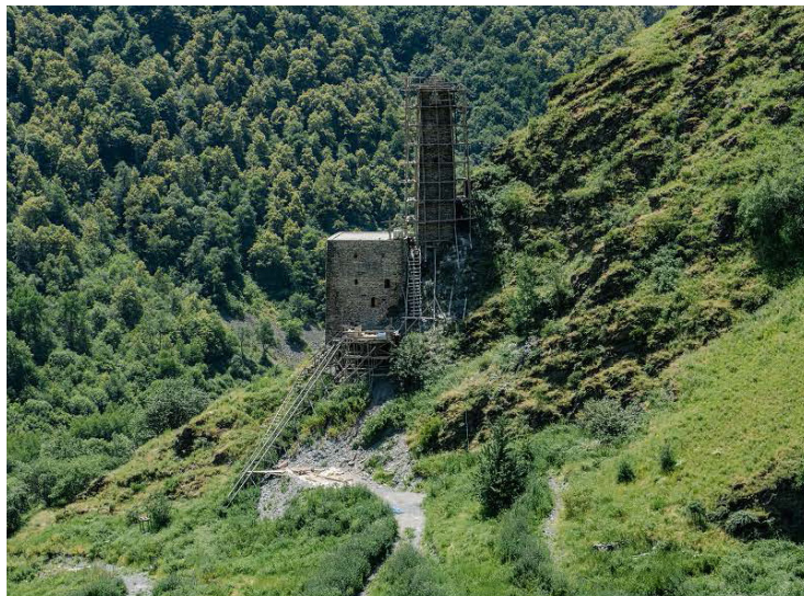
Рис. 2. Реставрационные работы на комплексе сторожевой и жилой башен. Июль 2022 г.
