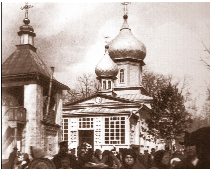
Рис. 23. Кладбищенская церковь Всех Святых. Вид с юго-запада. Фото 1909 года (Бардадым В. П. Зодчие Екатеринодара. Краснодар : Советская Кубань, 1995. С. 11)
