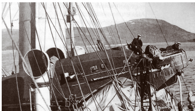
Илл. 13. Самолёт закреплён на палубе ледокола на специальном помосте. Фото из открытых источников
