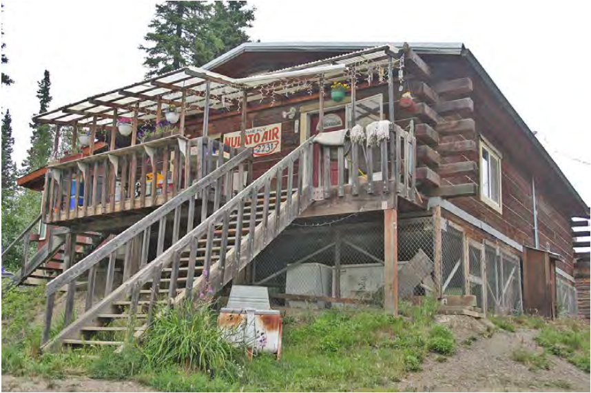
Дом на специальной конструкции-каркасе из металлических труб
