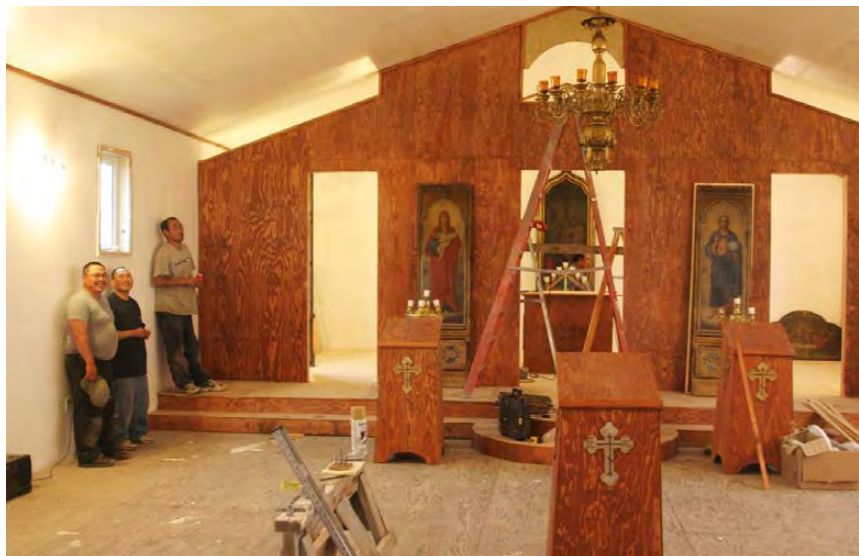
Работы по установке иконостаса
