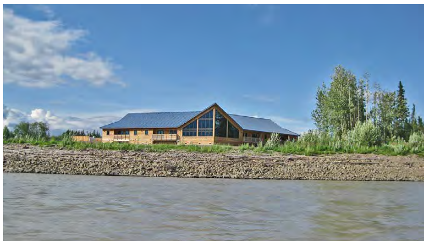
Здание Дома престарелых, выполненное в стиле конструктивизма, в пос. Галена
