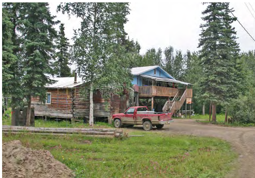
Дома на деревянных сваях-столбах и сваях из металлических труб
