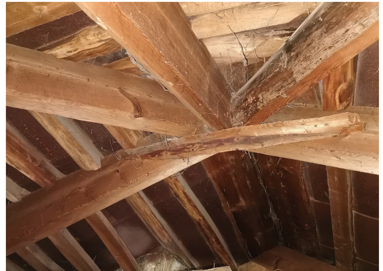
Соединение стропил вальмовой части
