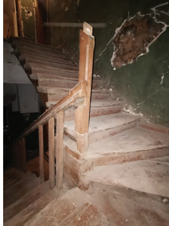
Южная лестница до реставрации
