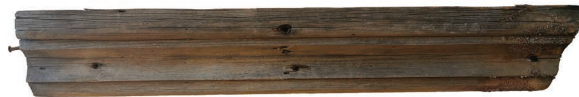
Профилированный карниз с башенки
