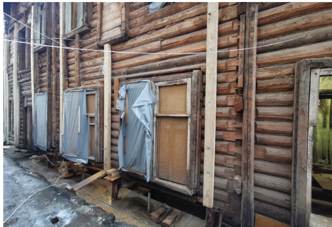
Дворовая стена в процессе реставрации. Сруб укреплен сжимами и вывешен
