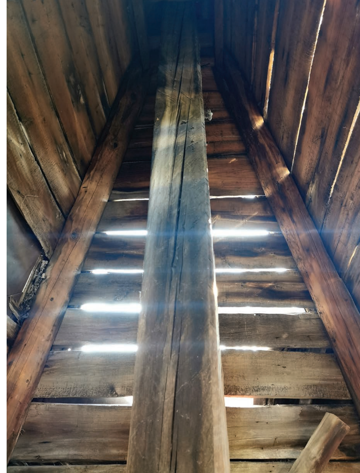
Мачта, стропила и обшивка досками внутри башенки
