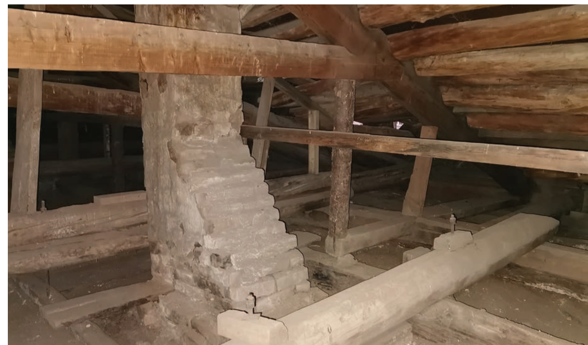
Чердак дома до реставрации
