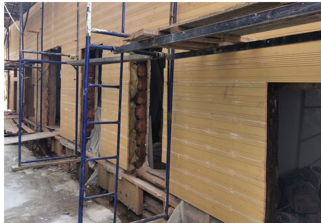
Обшивку пришлось воссоздавать полностью из нового материала в силу значительных утрат и ее плохого состояния. На новых досках в точности повторен исторический профиль
