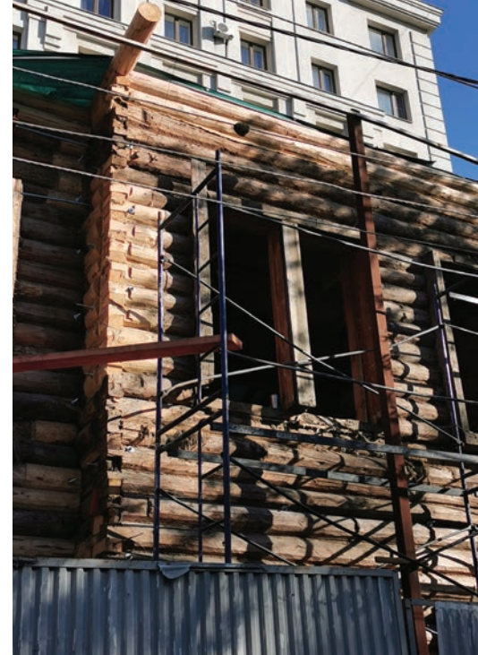
Замены сгнивших бревен сруба
