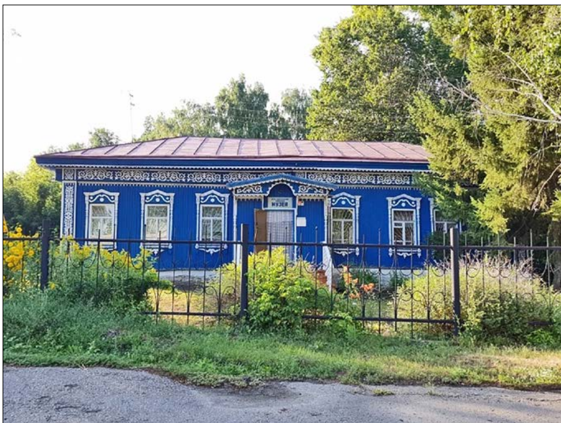
Рис. 18. Дом купца Морозова (ныне здание районного краеведческого музея)
