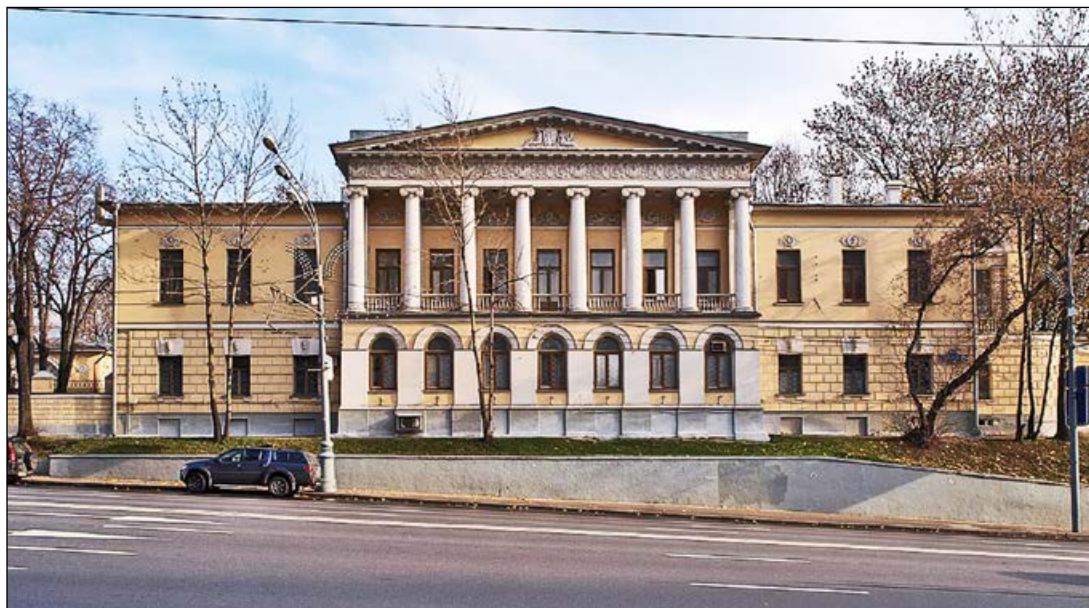
Рис. 3. Д. И. Жильярди, А. Г. Григорьев. Главный дом усадьбы Усачёвых-Найдёновых. 1826–1831 гг. Москва, ул. Земляной Вал, 53. Современная фотография
