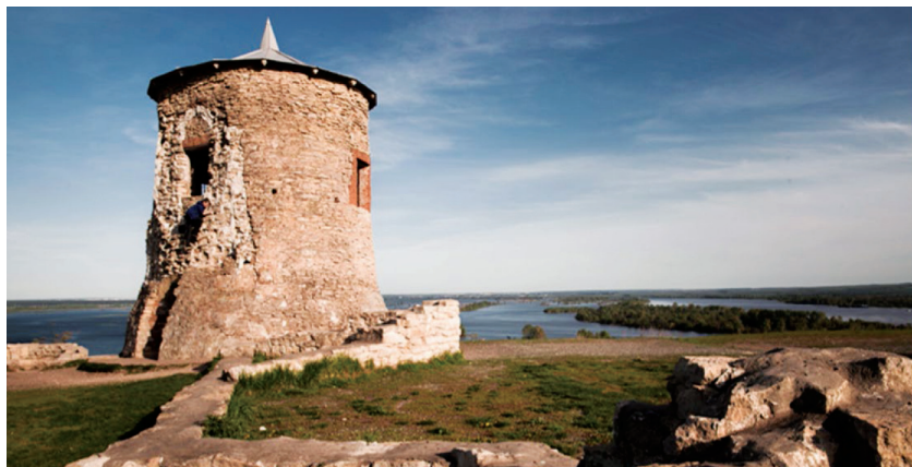
Рис. 23. Башня домонгольского периода в Елабуге 41
