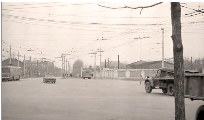
Рис. 83. Фрагмент градостроительного контекста Центрального кладбища Краснодара: западная перспектива улицы Северной от пересечения с ул. Шаумяна (ранее и ныне Рашилевская) в сторону пересечения с ул. Октябрьской. Справа — каменная ограда кладбищенского квартала. Фото 1962 г. Из архива С. В. Иванова
