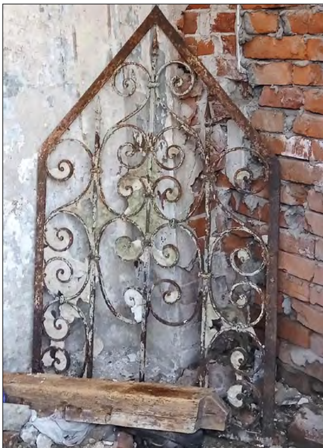
Рис. 101. Объект культурного наследия «Часовня Богарсукова», конец XIX в. — начало XX в. Демонтированная оконная решётка в юго-западном углу помещения. Фото В. В. Бондаря, 2024 г.
