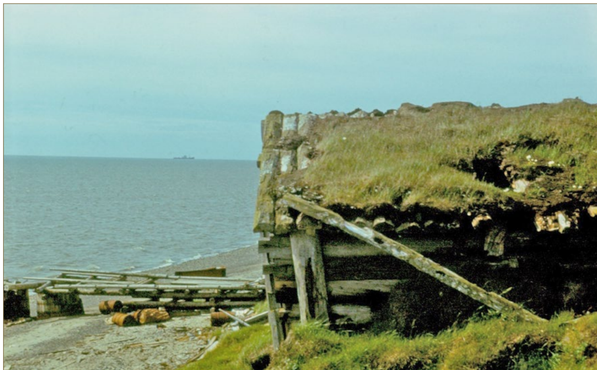
Остатки строения на берегу Баренцева моря в районе посёлка Бугрино
