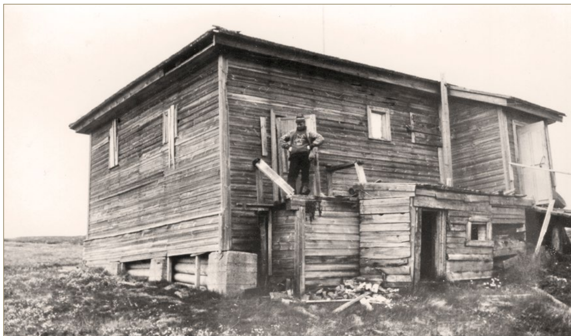
Здание маячной сирены
