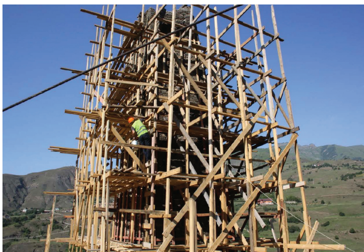
Рис. 3. Реставрационные работы на сторожевой башне. Июль 2021 г.
