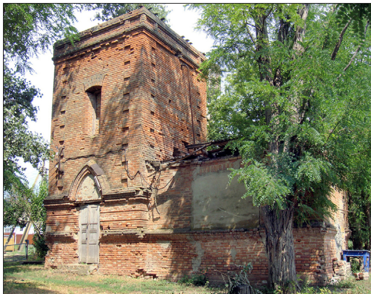
Рис. 7. Современный вид бывшей водокочки. 2021 г. Фото из архива УТООКНKK
