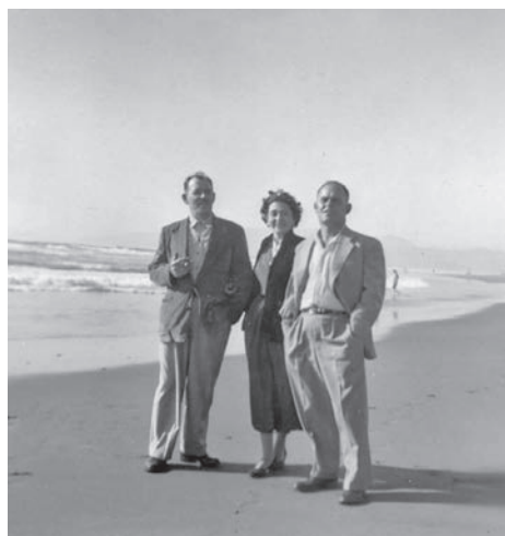
Борис Коновалов, неустановленное лицо, Павел Сухатин в историческом парке маяка Пиджин-Пойнт
