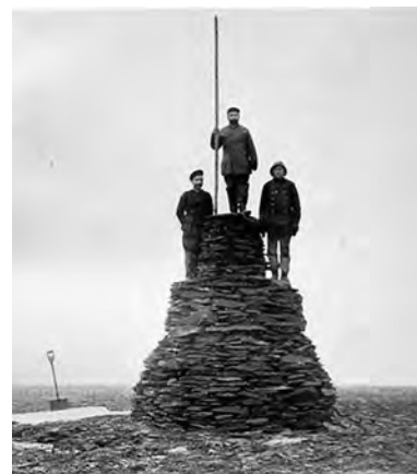
А. С. Васильев на сооружённом сигнале на мысе Ли
