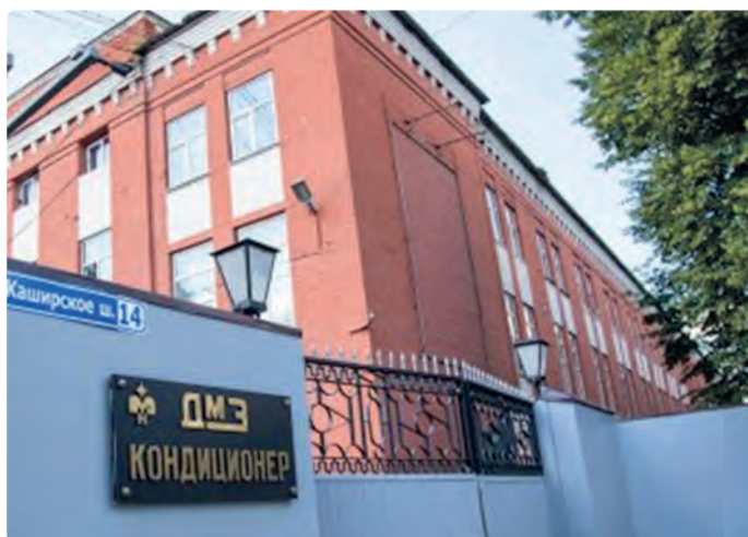
Домодедовский машиностроительный завод «Кондиционер» 88
