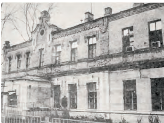
Вокзал ст. Домодедово, построенный в 1902 г. Альманах «Домодедовская белокаменная сторона». № 1. 2016
