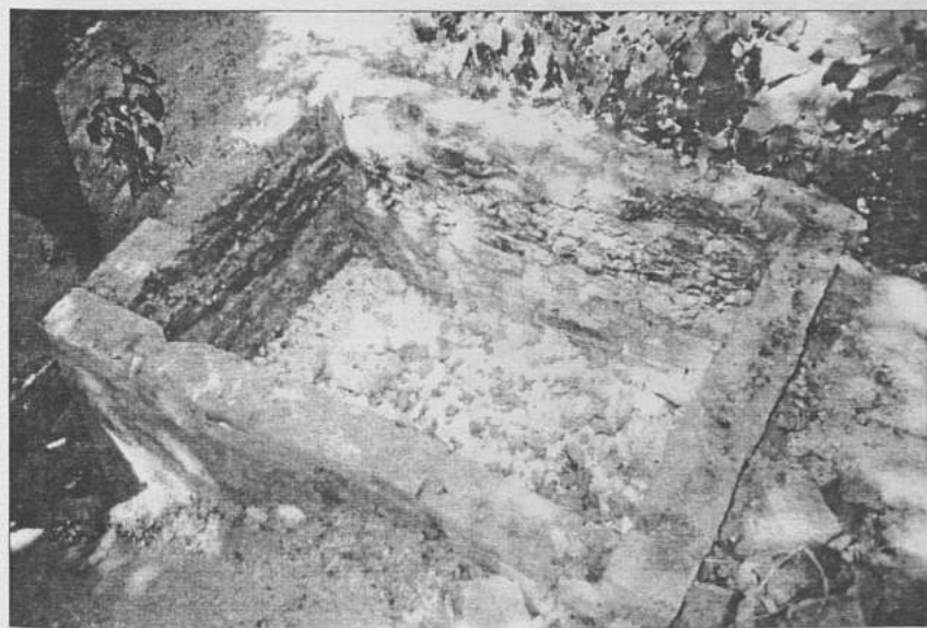
Печь после обжига известняка с остатками извести. На внутренних сторонах стенок ясные следы оплавки кирпичей как следствие высокой температуры. Станица Северская Краснодарского края, 2003 г.
