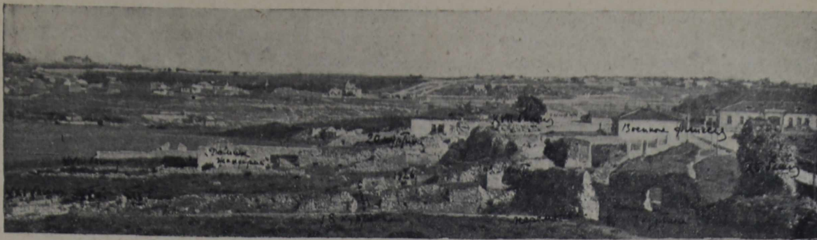
Рис. 1. Общий вид юго-восточного участка с севера.
