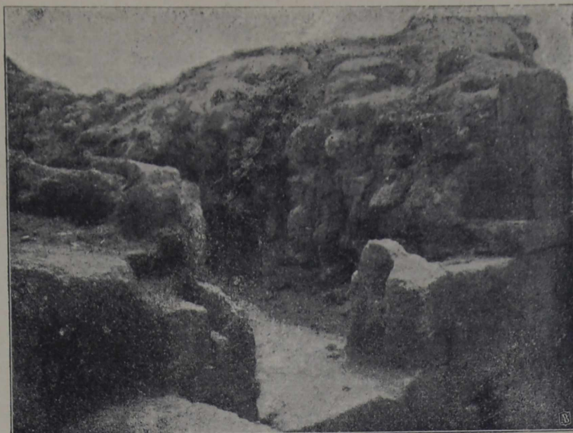
Рис. 83. Порог калитки 2-го яруса кладки 19 куртины. Вид с башни № XVI.
