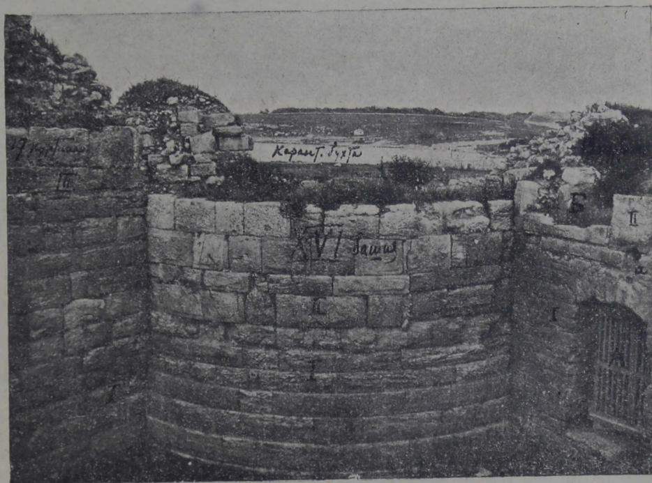
Рис. 19. Круглая башня № XVI. Слева к ней примыкает в переплет (5 рядов) 17 куртина. I—III—ярусы кладки. Справа примыкает в притык кладка 19 куртины; А—калитка I яруса; Б—калитка II яруса; а—водосток II яруса.
