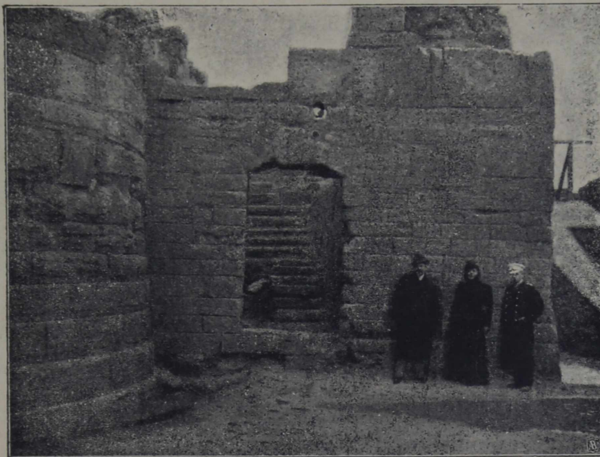
Рис. 79. I участок 19 куртины до поворота. Слева—башня № XVI. Над калиткой видны следы водопровода и водостока. Влево и выше от них—порог калитки эпохи 2-го яруса кладки. Снимок времени раскопки (1900).
