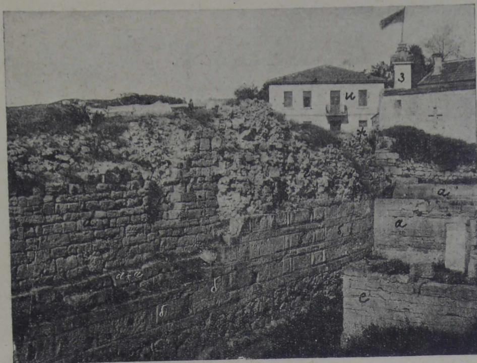
Рис. 21. Вид внутренней части 16 куртины со стороны города: a — два пилона ворот древнегреческого времени; б — I ярус 16 куртины. Кладка кордонами на ребро, плитами на образок. Стена стоит на бутовом фундаменте; б 1 — часть той же стены со стесанными рустами, так как в этом месте в позднейшую эпоху была устроена цистерна и стена города служила одной стеной цистерны; з — бут, уцелевший от разобранной кладки византийского здания, с цистерной в нем. Здание непосредственно примыкало к оборонительной стене; а — а — два ряда плашмя положенных плит от II яруса; d — кладка стены III яруса с углублением хозяйственного назначения (след от дома, пристроенного к стене); e — древнегреческое здание у ворот (казарма?); ж — византийская калитка над древнегреческими воротами; з , и — ворота и б. монастырская гостиница.
