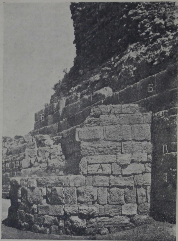
Рис. 15. А—полукруглая башня ранне-римского времени; Б—лицевая кладка поздне-римской или ранне-византийской башни прямоугольного плана; В—ее же фундаментная кладка; Г—часть 16 куртины оборонительной стены.
