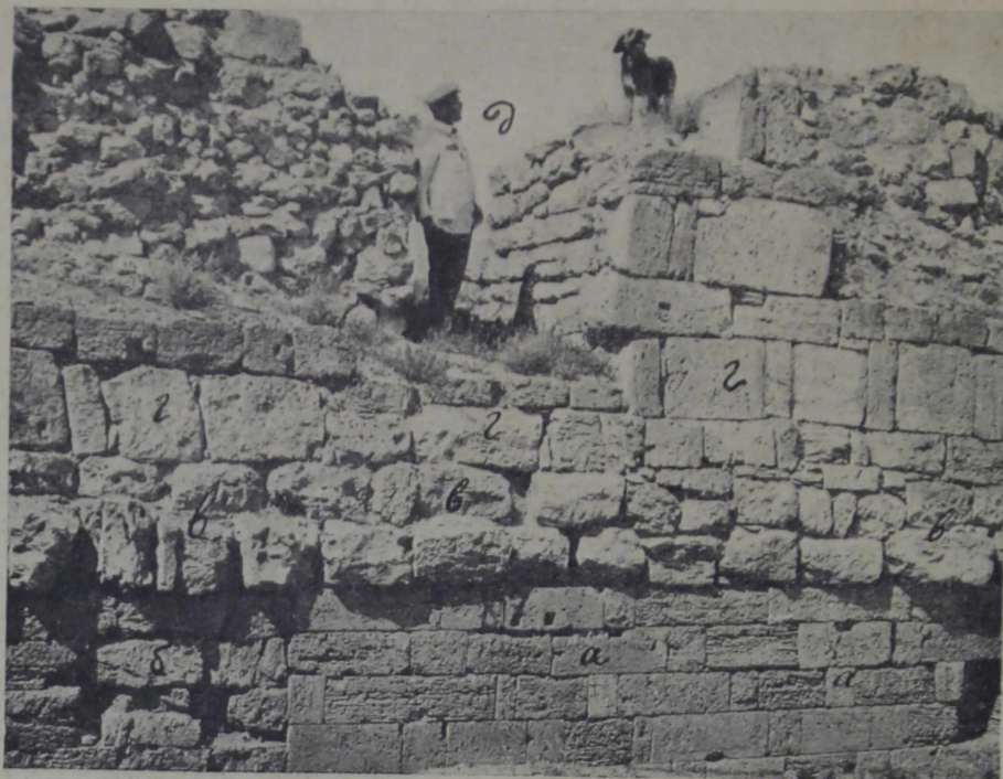
Рис. 88. Деталь кладок 19 куртины (снято с внутренней стороны): а — брусковая кладка 1-го яруса; б — следы какого-то древнего ремонта стены 1-го яруса; в — фундамент 2-го яруса, предназначенный быть в земле; г — кладка 2-го яруса; д — калитка в стене 2-го яруса возле часовни Леонтия (см. рис. 89, а).
