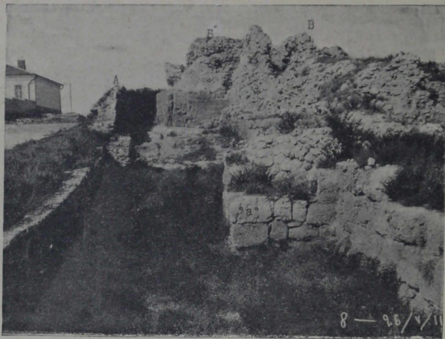
Рис. 76. Наружный фасад 20 куртины, перибол и протейхизма: А — протейхизма; В — башня Зенона (с сев.-востока); В — 20 куртина, видна только IV стена; а — выступ на месте боковой полукруглой башни № XVII 1 (см. генер. план). Снято со стороны Карантинной бухты.
