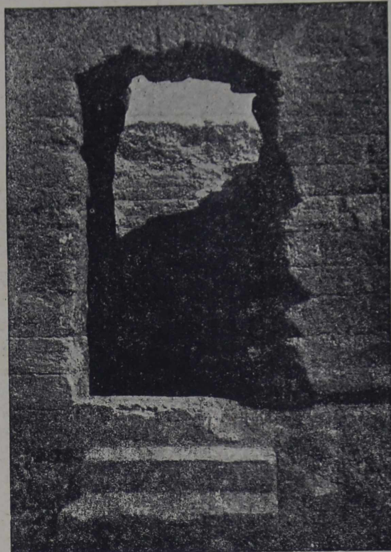
Рис. 81. Древнегреческая калитка I яруса кладки 19 куртины. Вид со стороны периболы (ступеньки новые).
