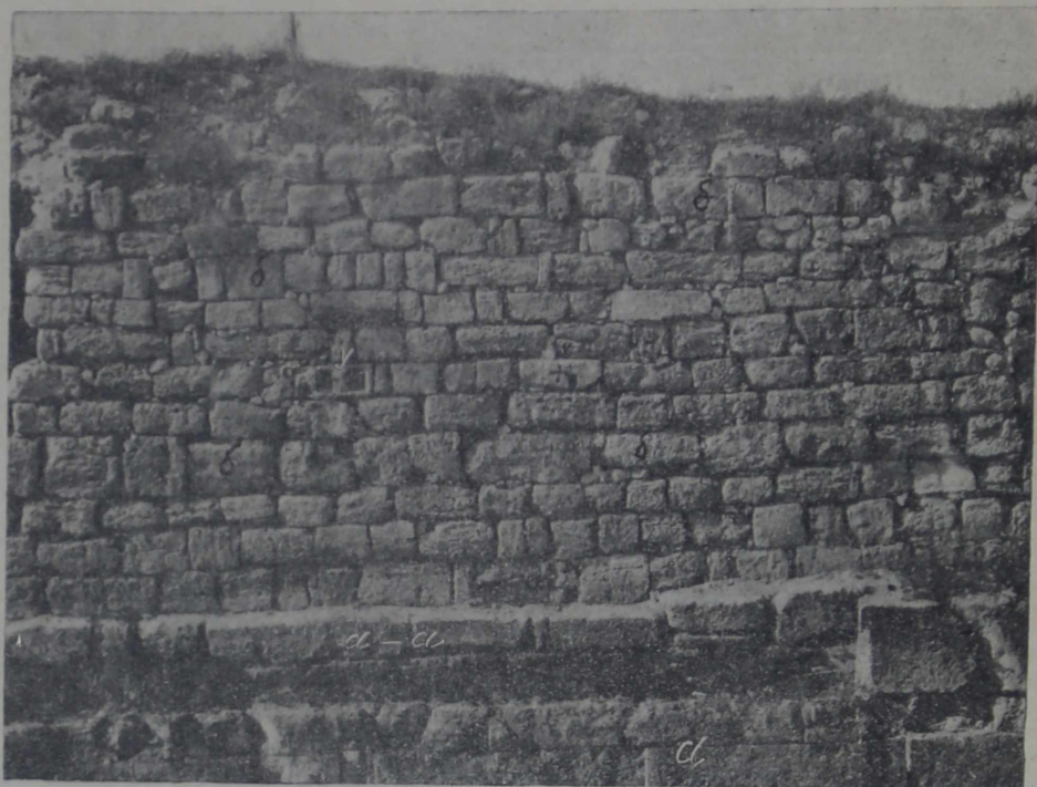
Рис. 22. Кладка 16 куртины, отрезок 10 (внутренняя часть): a —кордонная кладка I яруса (IV века до н. э.); a-a —часть кладки II яруса (вторично использованные кордонные камни из кладки I яруса); b —кладка III яруса византийской эпохи V—VII века; x —изображение креста ранней формы на камне, использованном вторично; y —камень с двумя углублениями.
