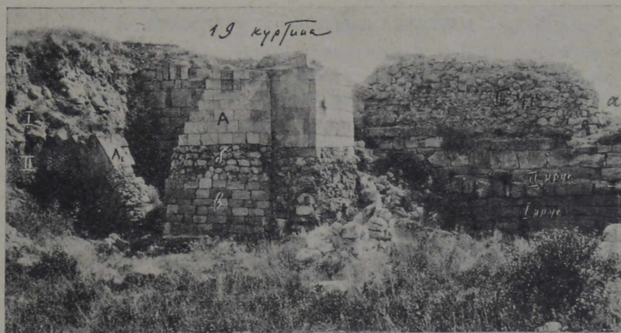
Рис. 90. Современное состояние внутреннего фасада 19 куртины с обвалившейся частью базилики Леонтия (до реставрации).
