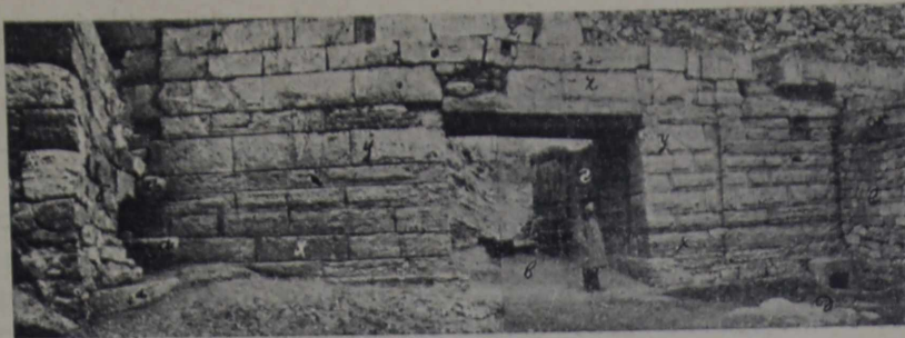
Рис. 6. Вид отрезков 16 куртины с древнегреческими воротами и склепами: a — остатки круглой древнегреческой башни IV в. до н. э. для защиты ворот; b — четырехугольная башня римского времени; в — древнегреческие ворота IV в. до н. э. (датируются предметами из склепа „д“); г — выступы ворот внутрь города для усиления обороноспособности; д — подстенный склеп № 1012, в котором найдены драгоценности IV в. до н. э.; e, жс — склеп эпохи имп. Тита I—II в. н. э. (в римское время был в земле до буквы жс ); x, y — кладка эпохи конца IV в. до н. э.; z — кладка римского времени; z 1 — порог калитки, выстроенной в V в. н. э. В то время уровень почвы значительно повысился.
