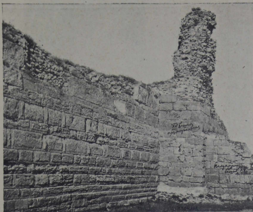
Рис. 14. Часть 16 куртины и комплекс башен № XV: I—III—три яруса кладки; а—лицевая кладка прямоугольной башни № XV; б—фундаментная кладка той же башни.
