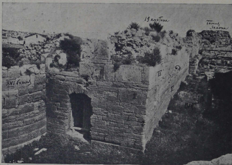
Рис. 80. 19 куртина с перемычки: I, II—два яруса кладки; б—углубление для площадки (?); г—стесанный угол; д—фундамент 2-го яруса; х—утолщение эпохи 3 кольца башни Зенона.
