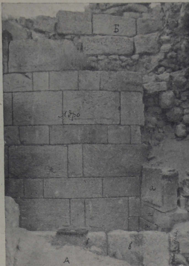
Рис. 63. Кладка древнегреческого ядра башни Зенона с остатком а кладки II стены 20 куртины; б —облицовка I кольца; А —начало III стены 20 куртины.
