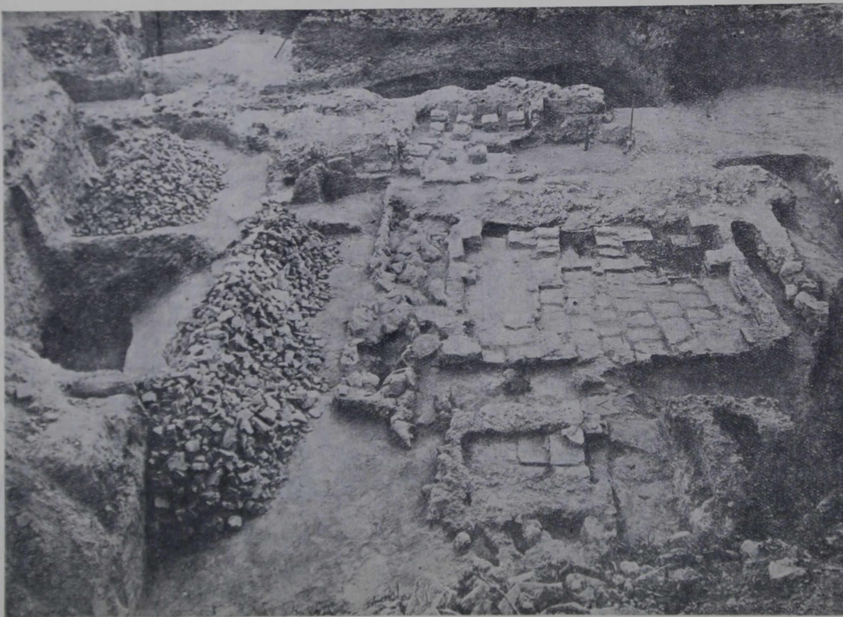
Рис. 180. Софийский заповедник. Печь для обжига кирпича. Общий вид после раскопок.
