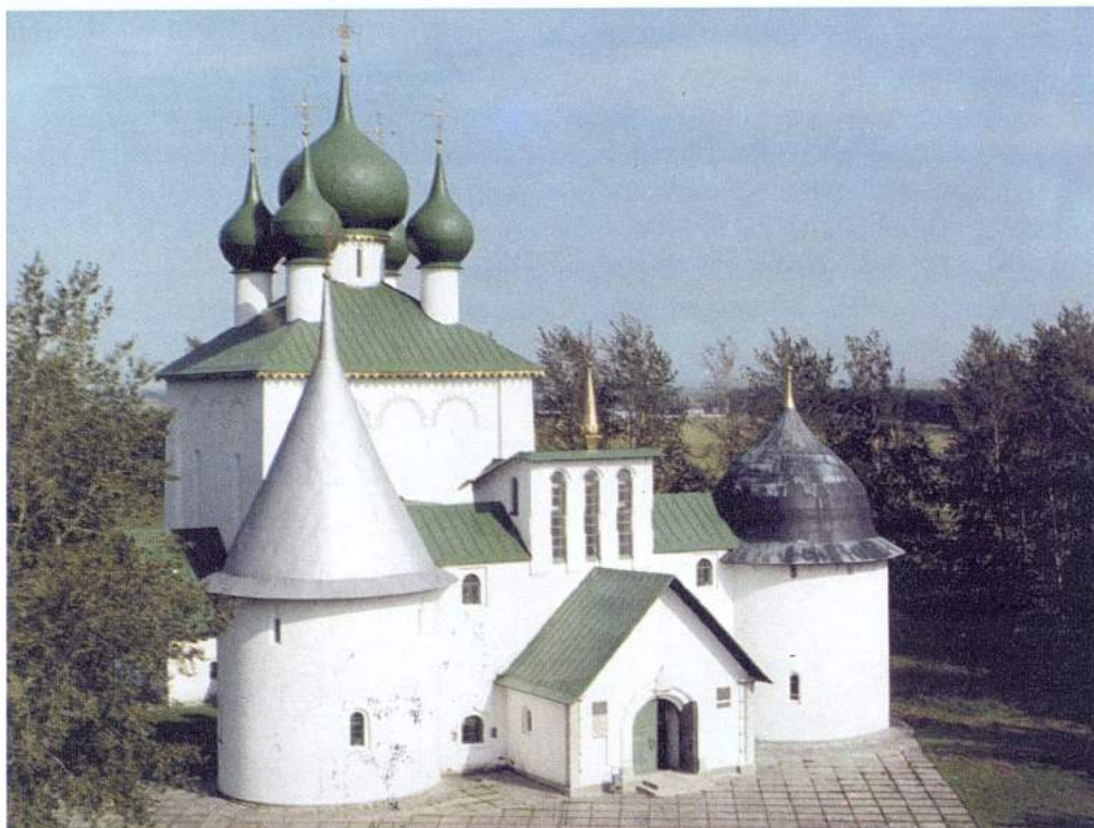
Храм Сергия Радонежского на Красном Холме 1913—1917 гг. The Sergey Radonezhsky temple on the Red Hill. 1913—1917
