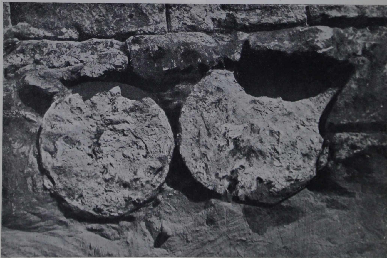
Рис. 18. Части колонн в кладке западного крыла стены детинца.
