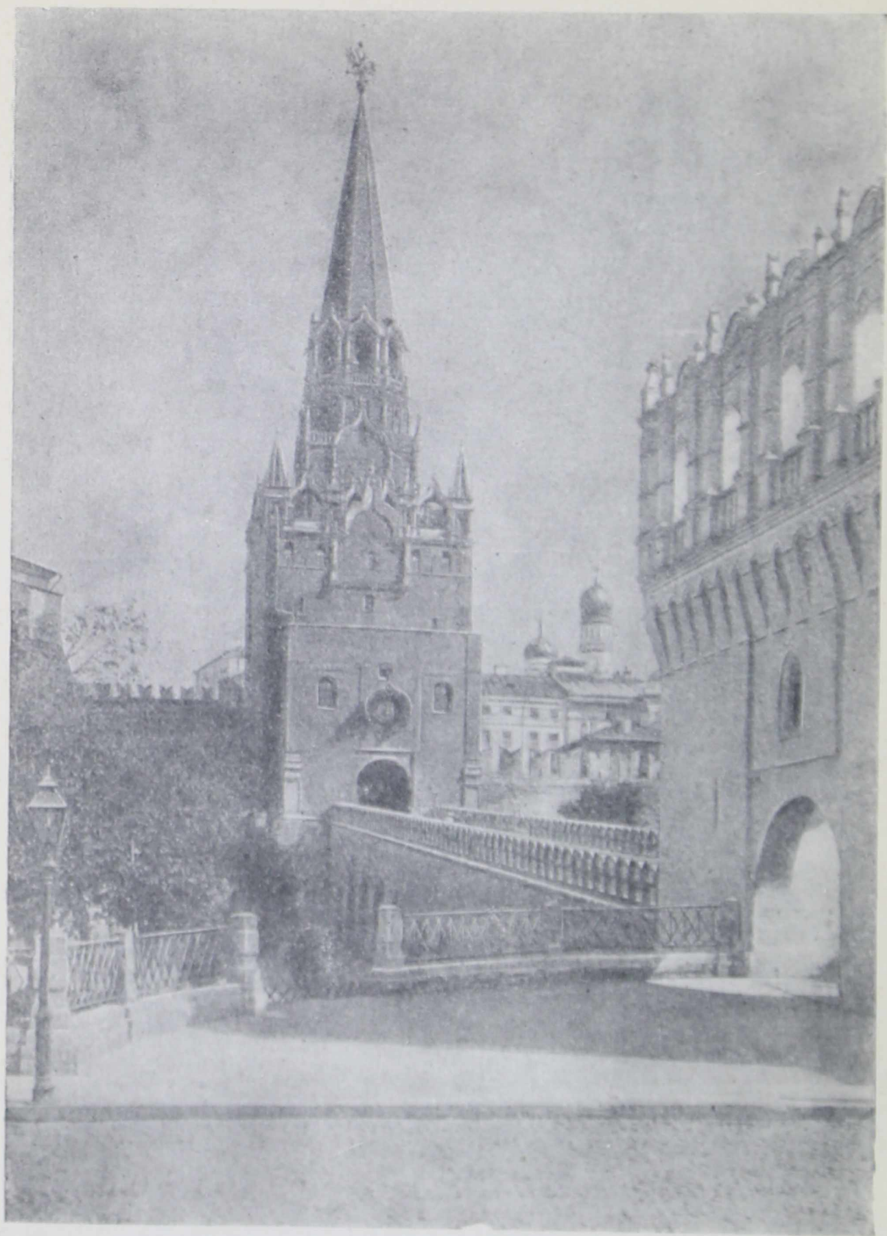
Троицкая башня Московского Кремля (90-е гг. XV в.) и отводная стрельница «Кутафья» 1516 г. (справа) Верх Троицкой башни 1685 г. Каменный мост перестраивался, но сохраняет формы 1516 г.
