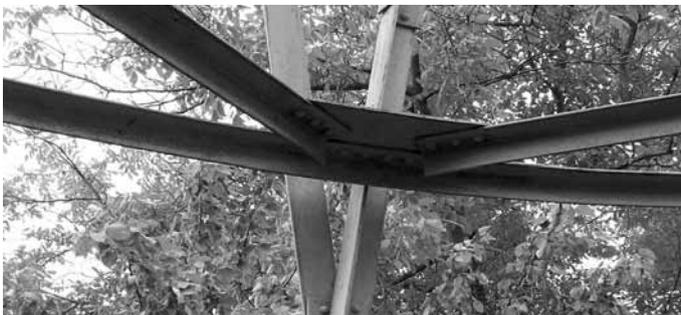
*Фрагмент сетки ствола – соединение ног между собой и с горизонтальным кольцом. Соединение горизонтального кольца с десятиугольной пространственной диафрагмой. Соединение частей ноги*
