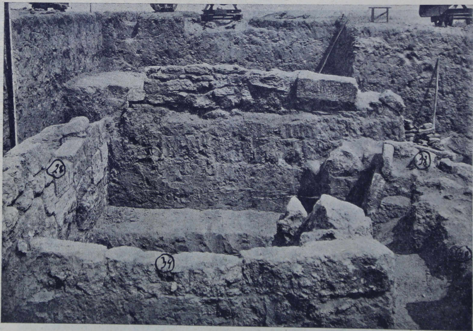
Мал. 5. Фундаменти будівлі 2-го шару ділянки Б.
