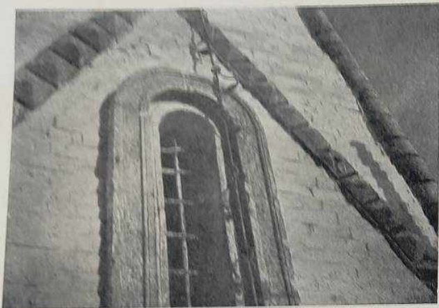
Верхняя часть окна на южной грани шатра
