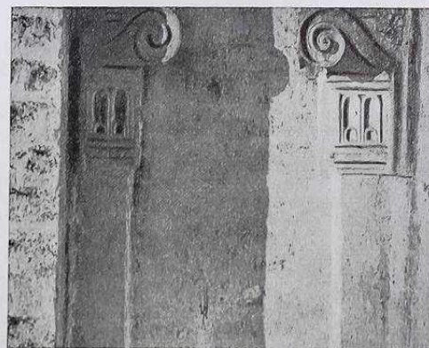
Угловые капители малых пилястров, несущих стрелы (боковая стена)
