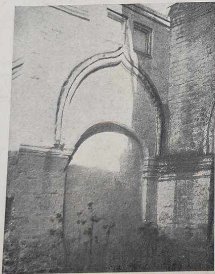
Деталь южной стены северного крыльца
