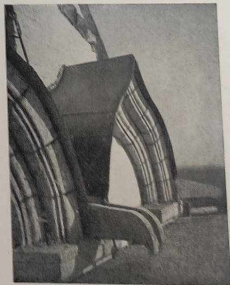
Детали кокошников и водометов южной стены восьмерика
