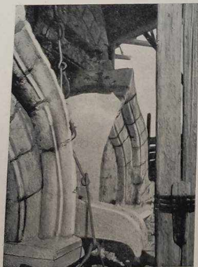
Детали кокошников и водометов южной стены восьмерика. Между кокошниками видна цепь железной стремянной лестницы
