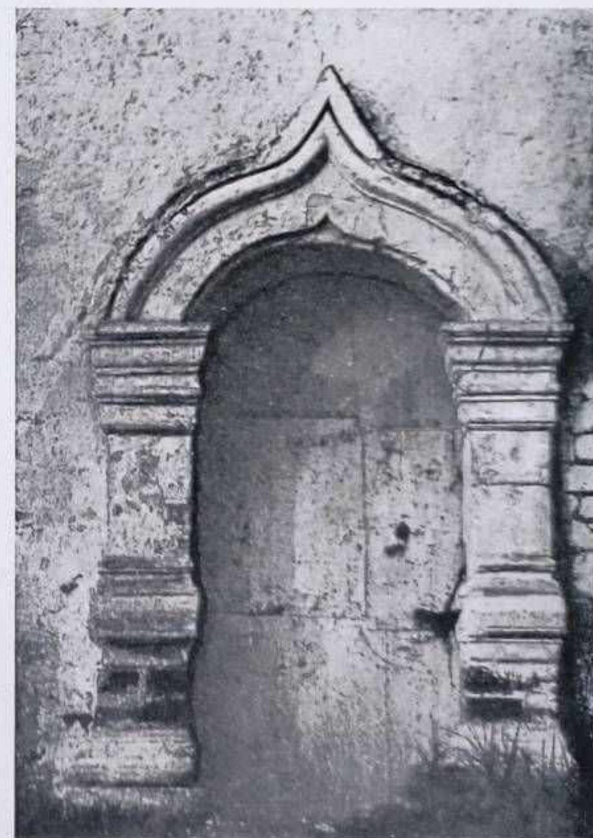
Обработка проема двери в камору под верхней площадкой северного крыльца
