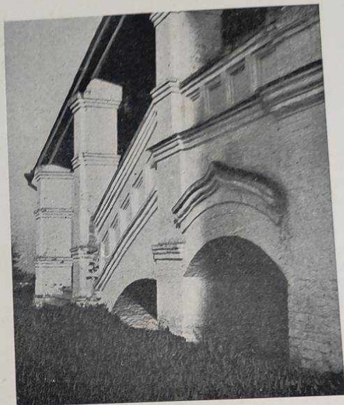
Деталь обработки арки под средней площадкой западного крыльца
