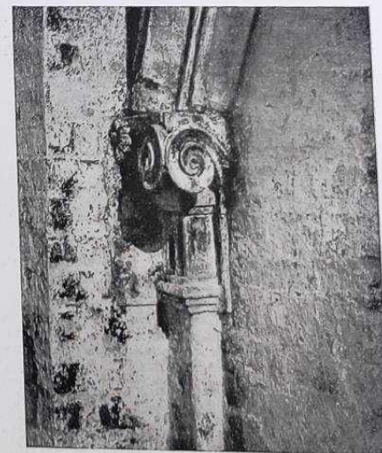
Угловые капители малых пилястров, несущих стрелы (боковая стена)
