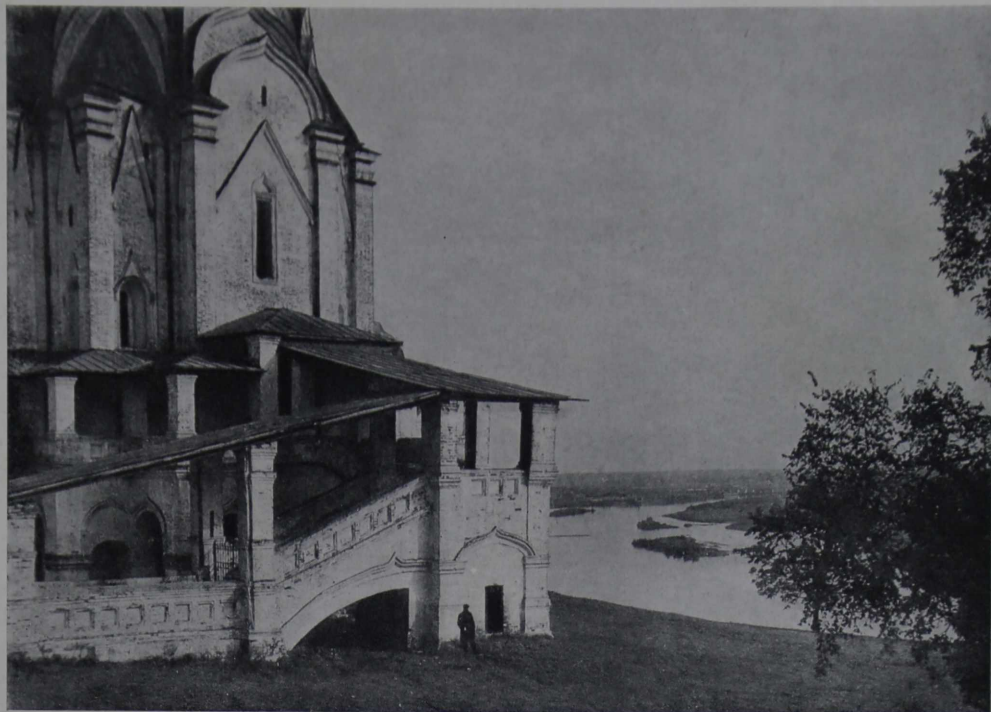
Фрагмент южного фасада
