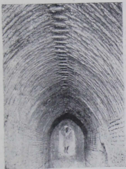
15. Кырк Кыз. Перекрытие коридора.
