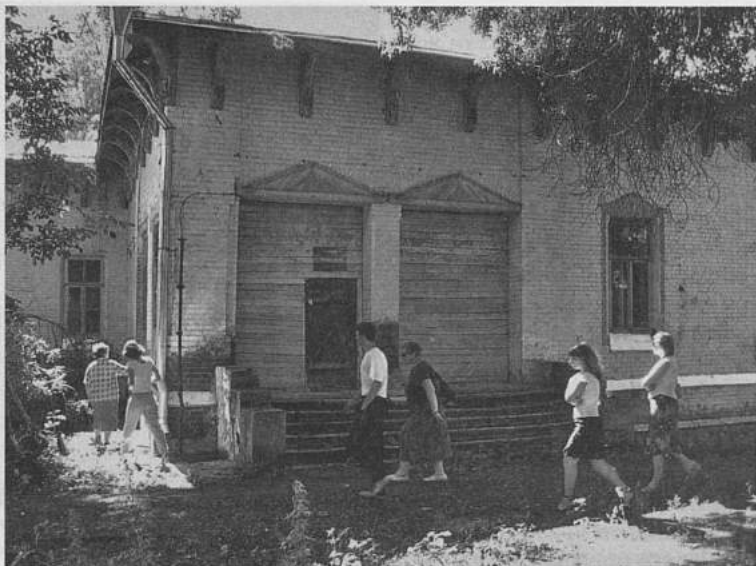
Крытая терраса на западном фасаде
