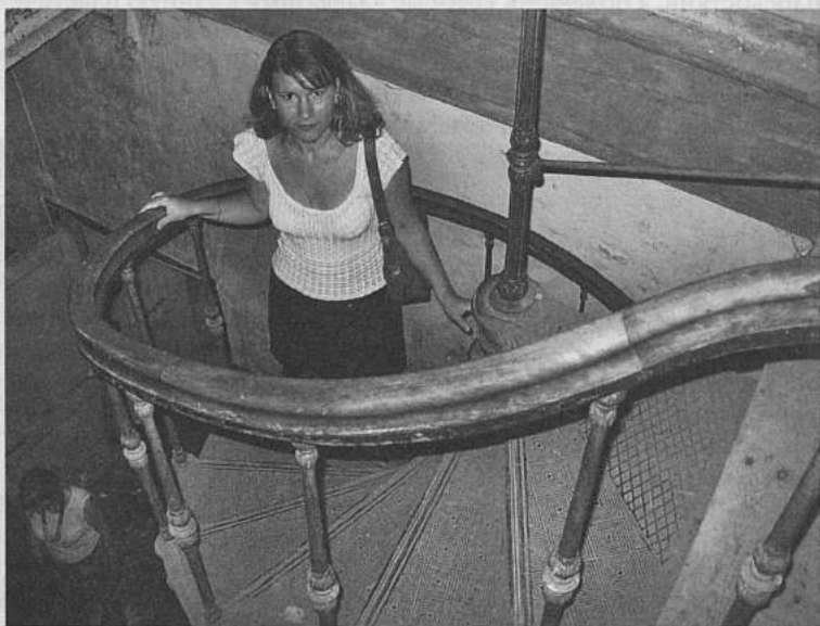
Чугунная винтовая лестница
