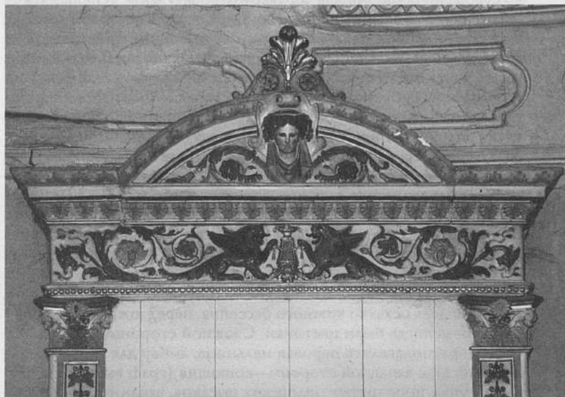
Деталь изразцовой печи в гостиной в левом ризалите
