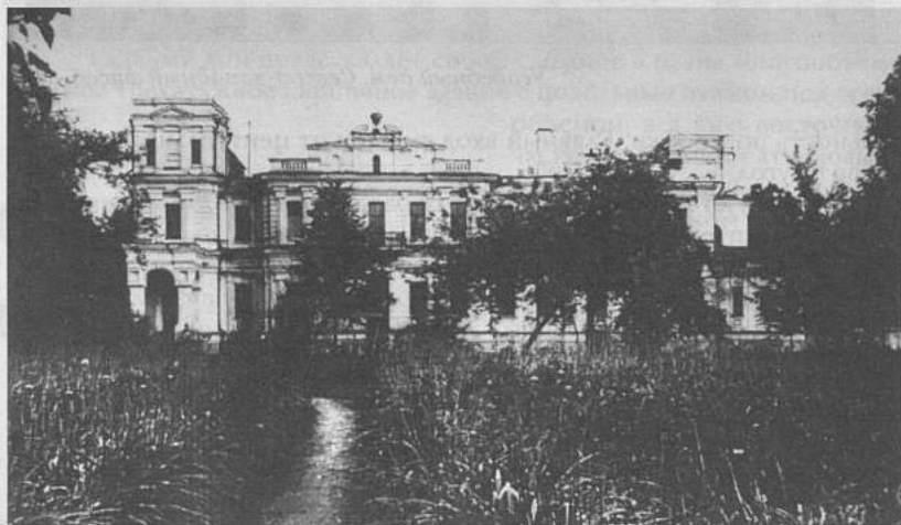
Степановское-Павлицево. Северо-западный фасад усадебного дома. Из частной коллекции Б. М. Рудченко (Москва). Фотография 1982 г.
