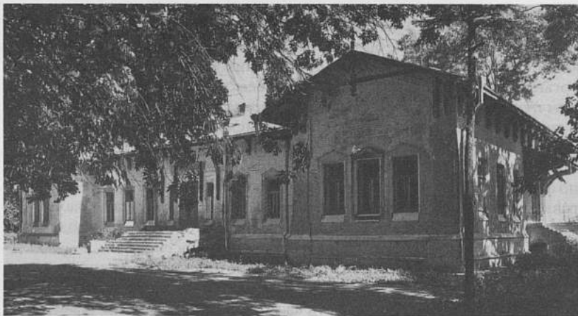
Вид на южный (парадный) фасад усадебного дома
