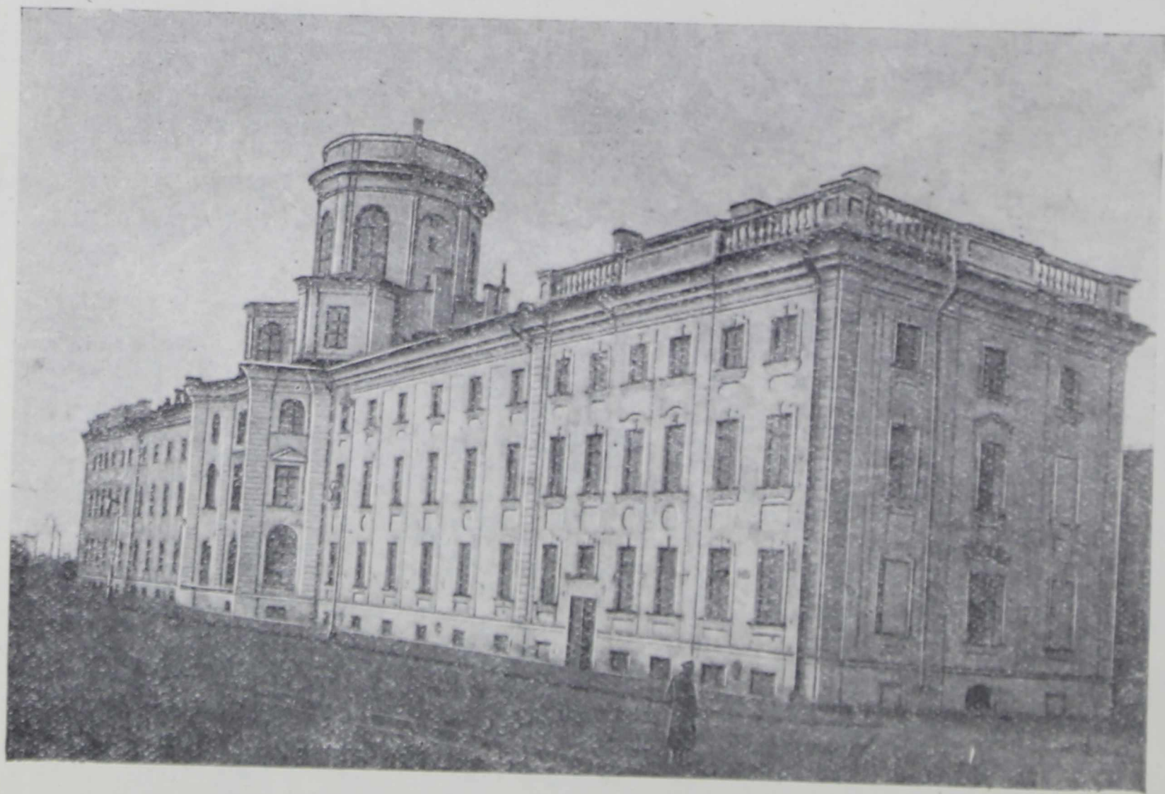
Рис. 6. Современный вид здания по Университетской набережной.
