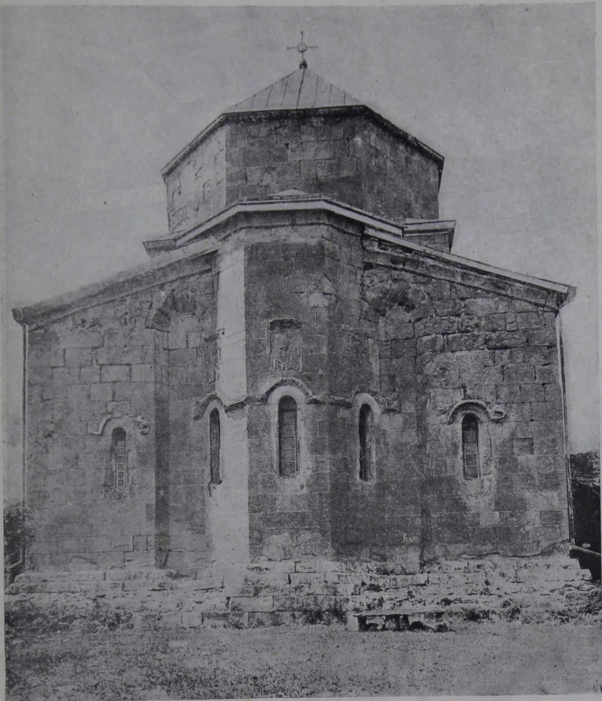
19. Восточный фасад Джвари
