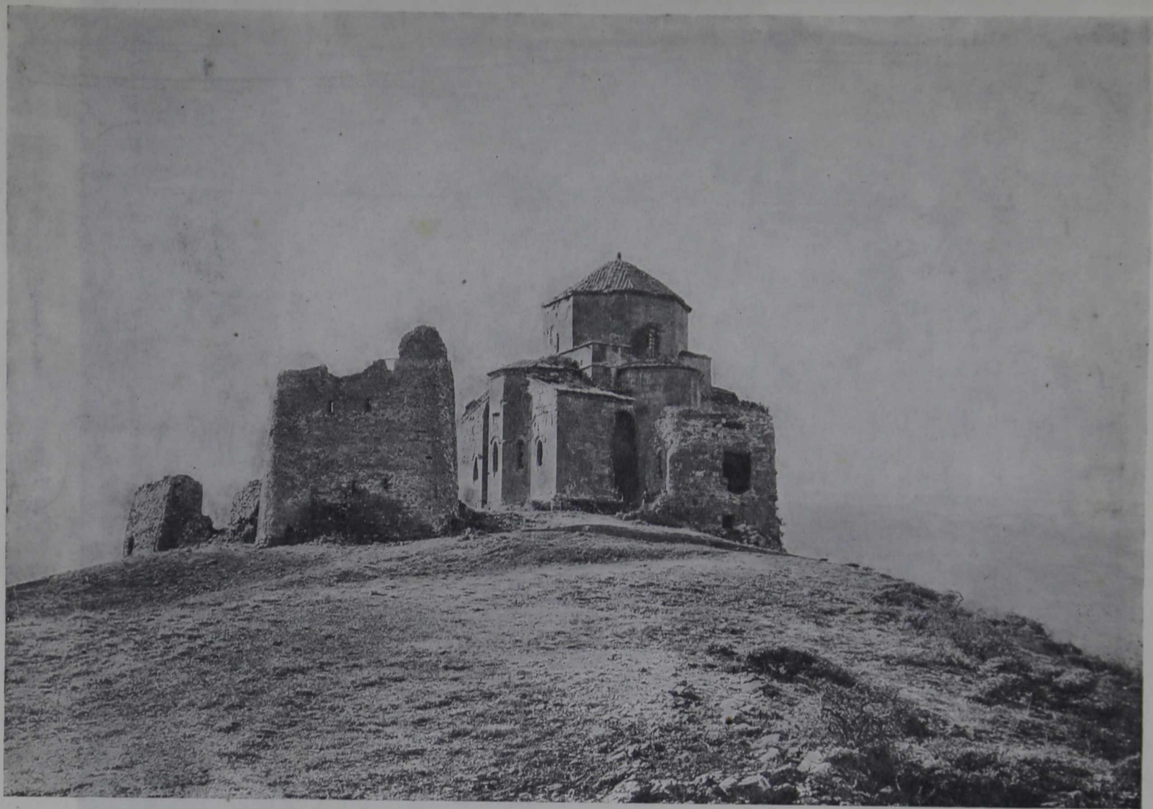
17. Северо-восточный фасад Джвари
