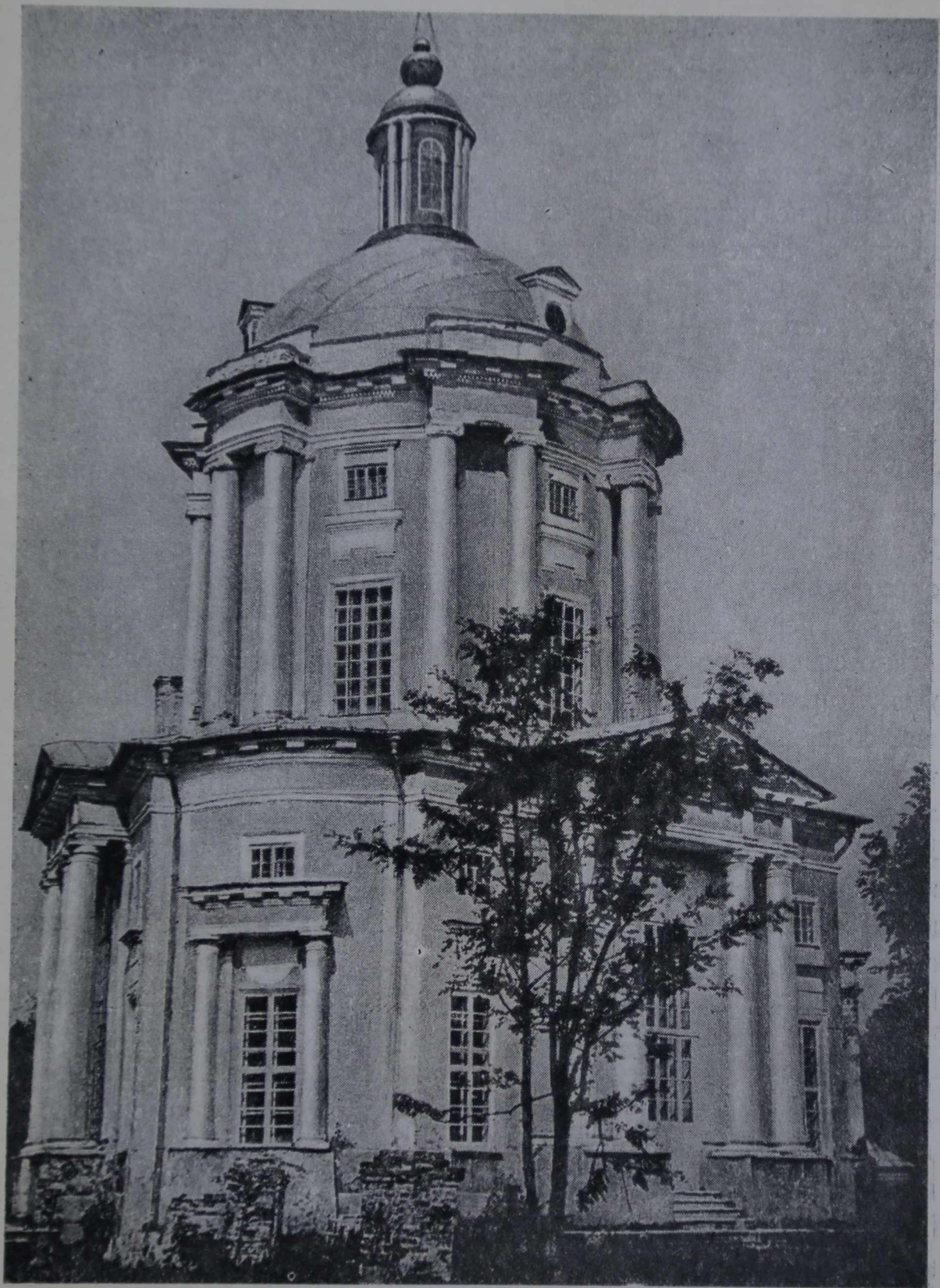
Церковь в селе Виноградово. Общий вид
